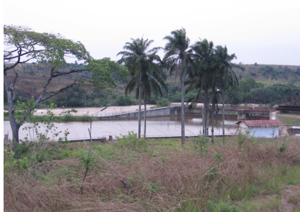
Fig.1.6d. Barrage de Sanga
