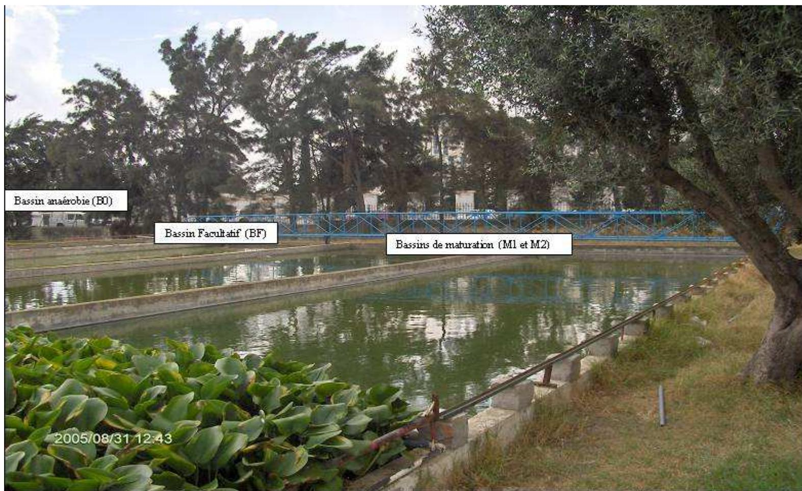
**Figure II-1** : Vue générale de la station pilote de lagunage naturel du CERTE (Tunis)
