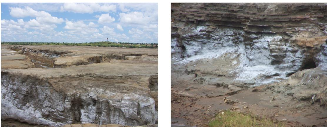
**Figure 6 - Photographie montrant la formation de gypse lors des infiltrations des eaux (zone d'effondrement aux tailings de Kipushi)**
