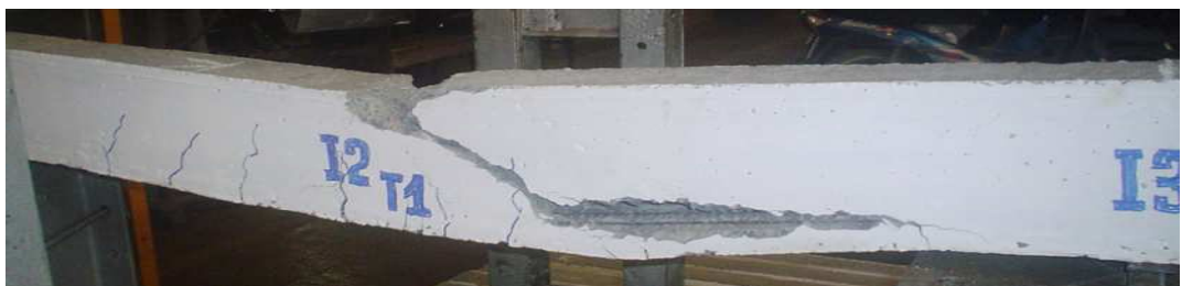
Figure 3.25 – Endommagement et rupture des poutres sans étrier
