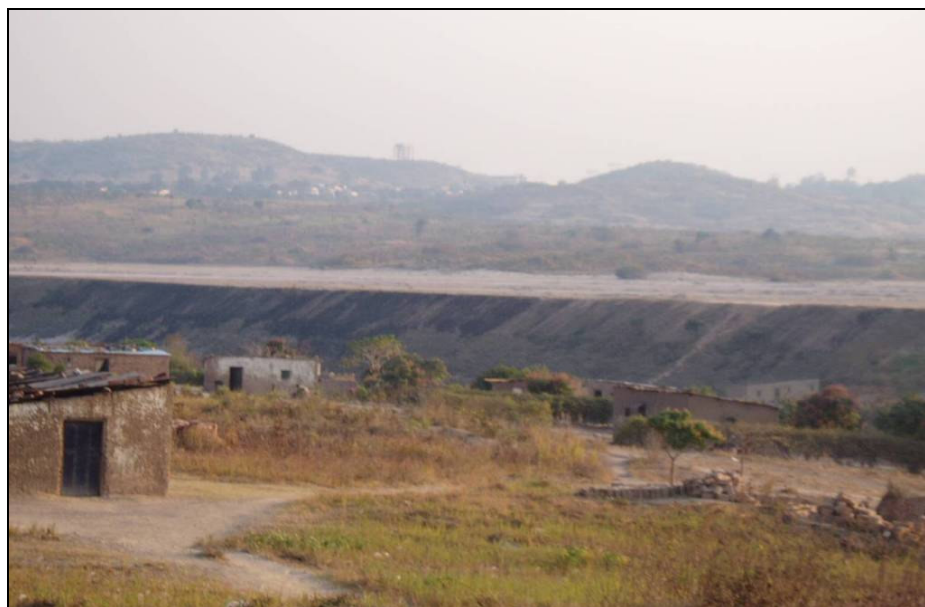
Figure III.16 Vue du bassin à rejet de Shituru
