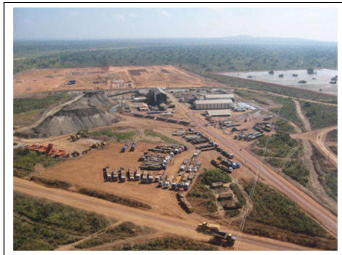
Figure III.11 Vue du site de Ruashi Mining avec, à droite, le bassin à rejet (Source : www.ruashi.com )
