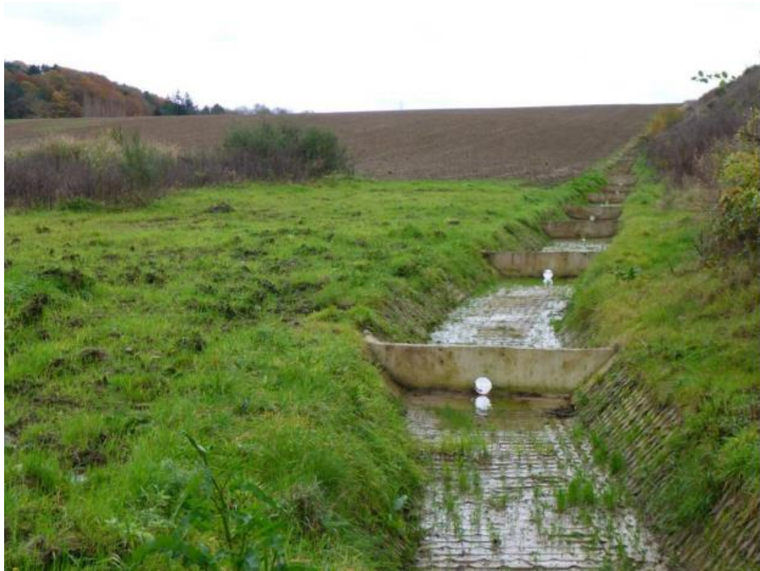
Figure 84 : Fossé large en dalles de béton ajourées (GISER)
