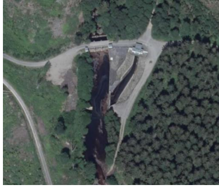
Figure 90 : Déviation du tunnel de la Helle : L'écoulement de la rivière est en partie déviée par le tunnel de la Helle, dans le bras de droite, et le reste est restitué à son cours naturel.
