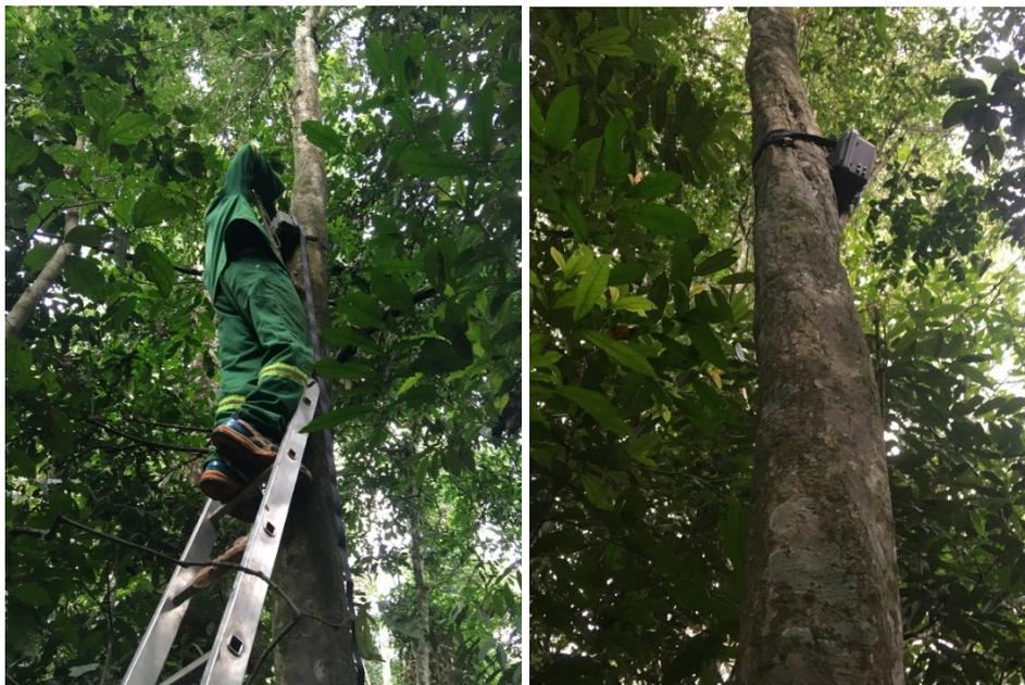
Photo 3 : A. Phase d'installation d'un capteur acoustique à 5 mètres de haut. B. Installation définitive du capteur avec le microphone placé de côté.
