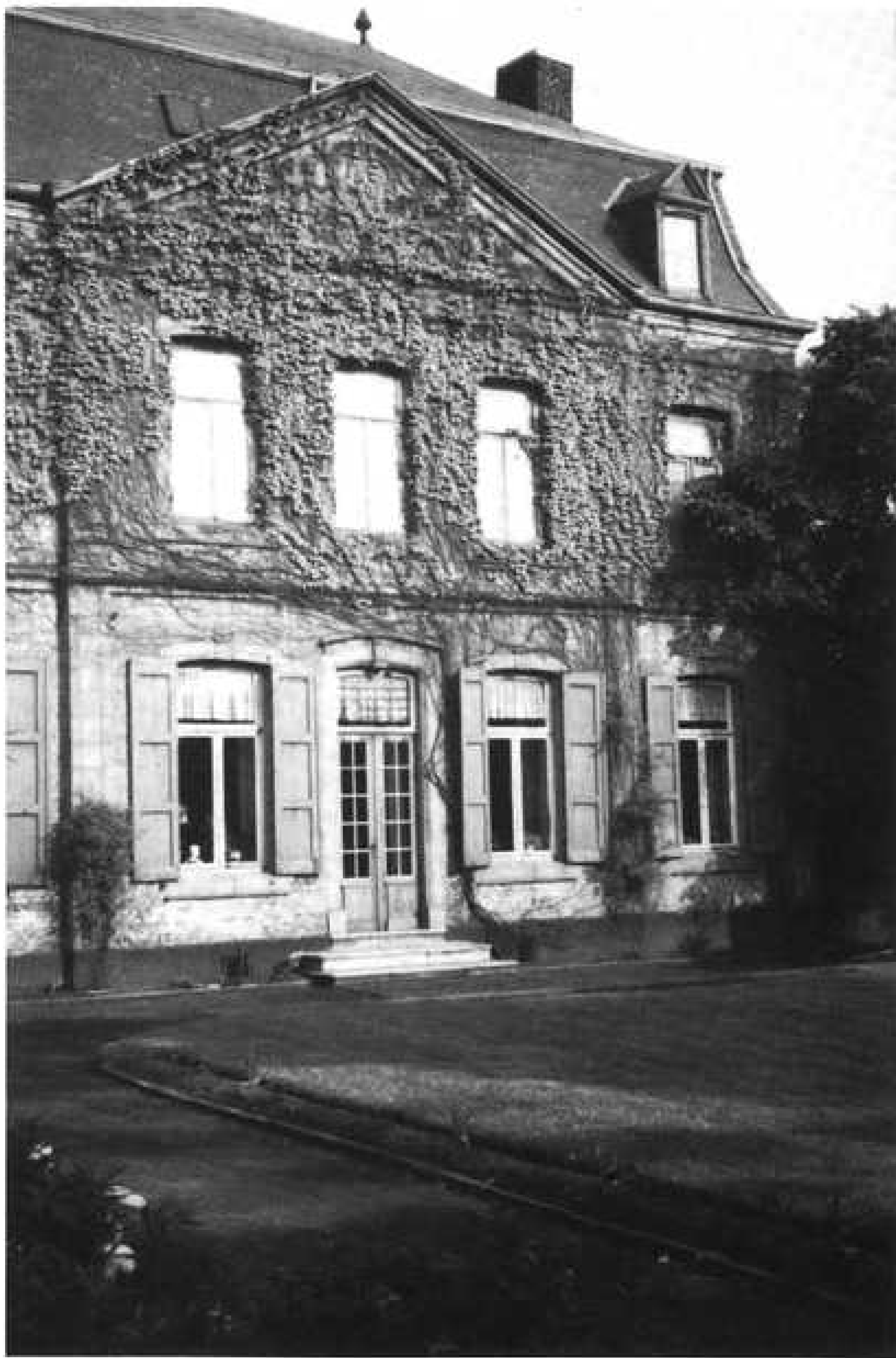
Vue partielle de la façade, d'après une photographie prise vers 1955.
