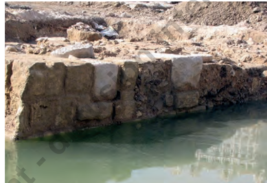
Fig. 6. Mur sud dans le secteur 2, vu du Nord (Photo Francis Choëï).
