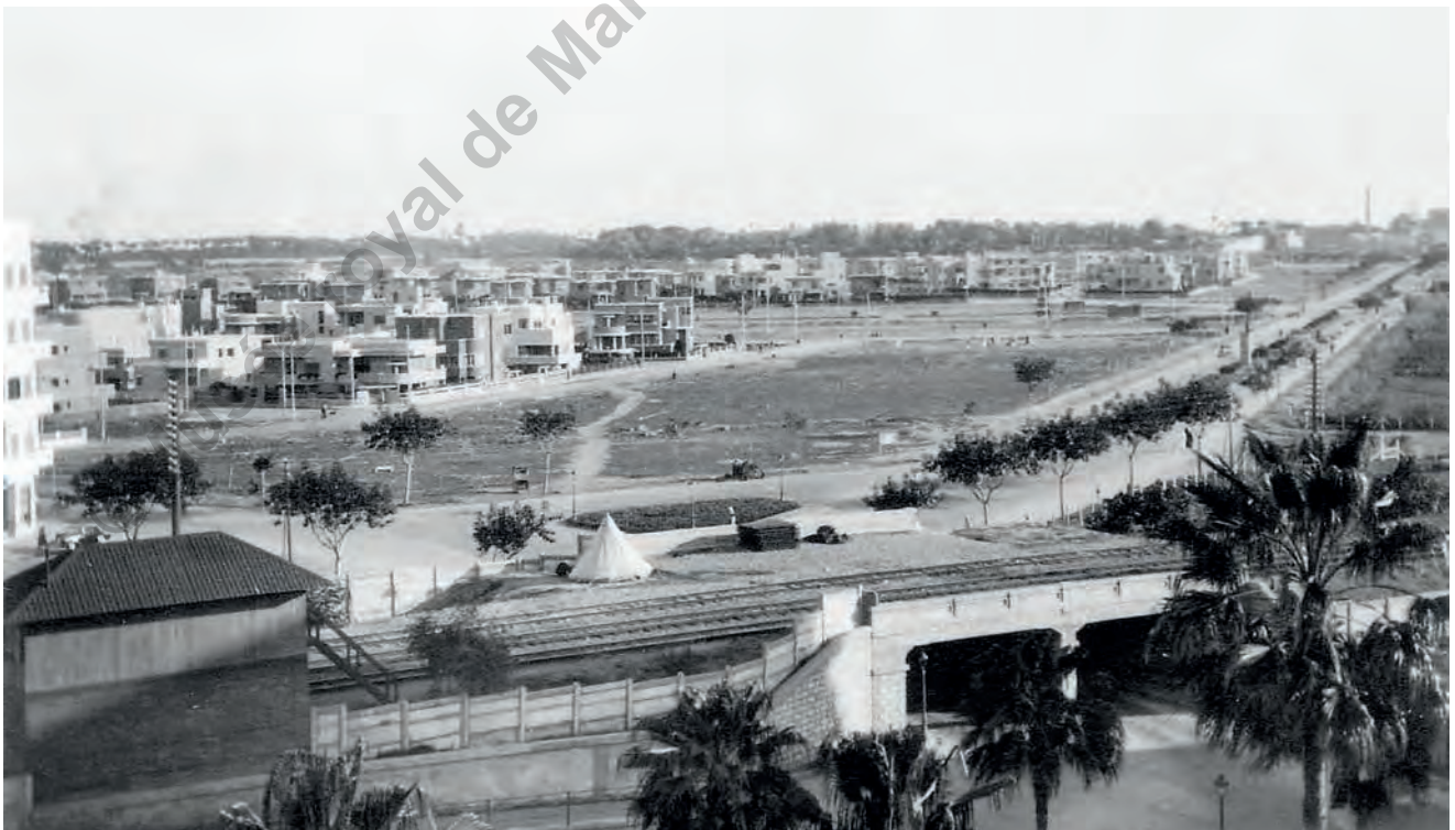
Fig. 2. Vue générale de la Cité Smouha, depuis le tunnel Ibrahimiah (Archives de Sandro Manzoni).
