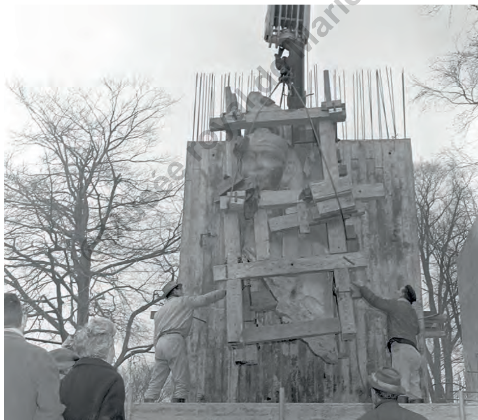
Fig. 17. Transfert du buste colossal de la salle des marbres vers le nouveau musée en construction et fixation sur un voile en béton. Photographie, vers 1967. Musée royal de Mariemont (© Musée royal de Mariemont. Photo Michel Lechien).
