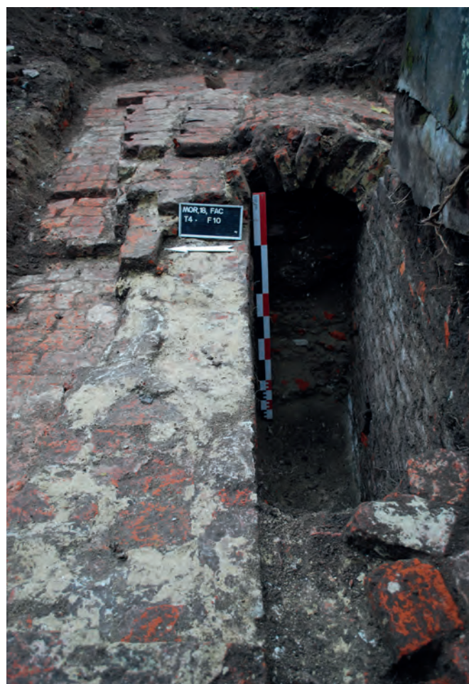
Fig. 44. Dans le sondage 6, le canal entre les murs technique et écran a été couvert d'une voûte en brique. Sur la plaque d'informations, le numéro de tranchée est erroné (© M. Dosogne, AWaP/DZO)
