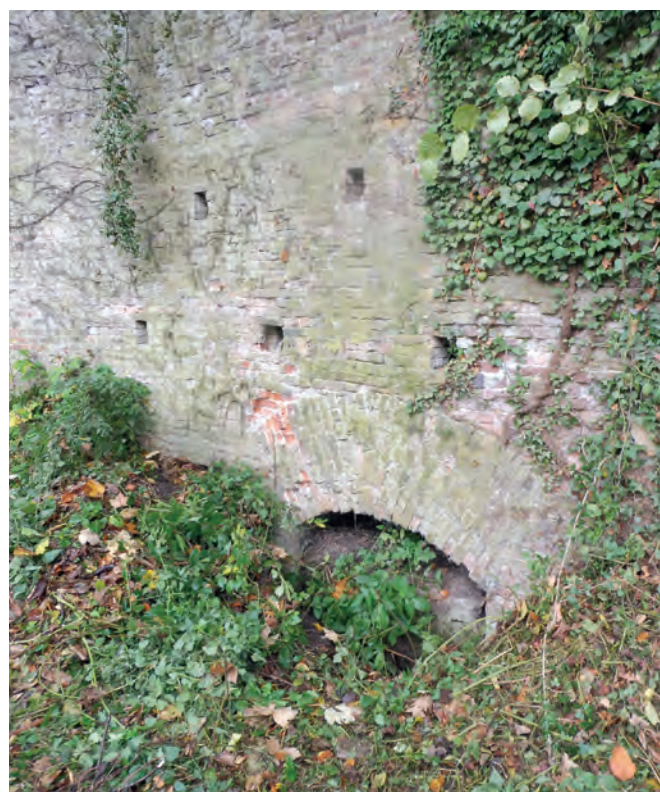
Fig. 31. Quelques-uns des canaux de drainage sillonnant le mur de rampe actuel et le sommet d'une cavité voûtée observée au pied du même mur à l'est de la loggia (© M. Dosogne, AWaP/DZO)
