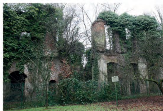
Fig. 12. Vues des vestiges en lien avec le relevé établi par la SPRL Thermobat, juin 2010. A. L'aile des écuries ; B. La cour d'honneur ; C. L'orangerie ; D. L'aile des cuisines ; E. Le corps de logis (© MRM)
