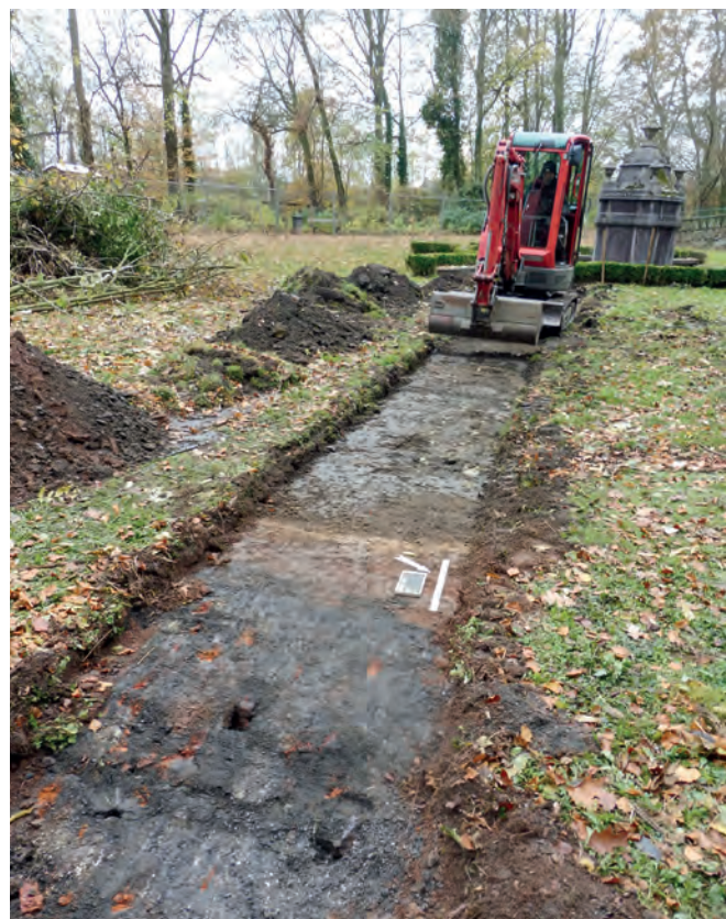
Fig. 33. La pelle mécanique de faible tonnage à l'ouvrage dans le sondage 4 (© M. Demelenne, MRM)
