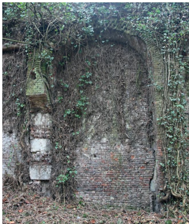
Fig. 20. Mariemont, orangerie, l'une des sept baies méridionales refermées par une maçonnerie de brique (© M. Demelenne, MRM)
