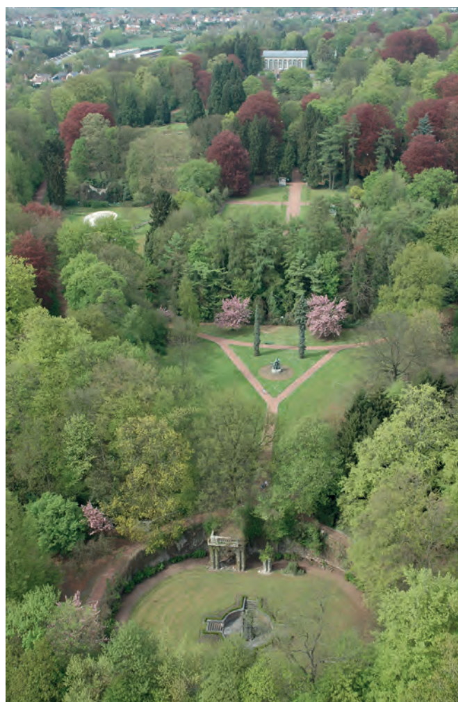
Fig. 1. Vue aérienne du Domaine de Mariemont. Succession des terrasses et en contrebas le « fer à cheval » et les vestiges de la loggia, juin 2006 (© MRM)
