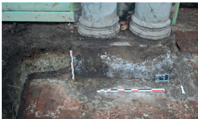
Fig. 43. Dans le sondage 6, sur les fondations de la loggia originelle en briques, la couche de mortier rose apparaît sous les aménagements en ciment postérieurs (©M. Dosogne AWaP/DZO)
