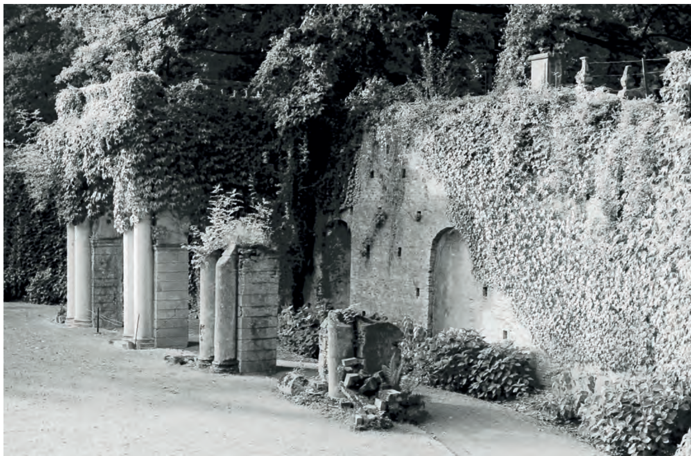
Fig. 49. Le « fer à cheval » en 1985. Des fûts en asbeste remplacent les fûts de colonnes des deux premières travées (© J. Leclercq)
