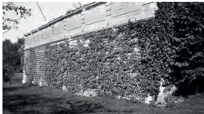
Fig. 21. Mariemont, orangerie, les sept baies méridionales originelles complètement refermées, début du XX e s. (?) [source: QUAIRIAUX et al. 2005, p. 74]
