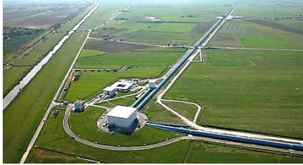
L'interféromètre franco-italien VIRGO (près de Pise) deux bras orthogonaux de L = 3 km collaboration entre cinq pays européens
