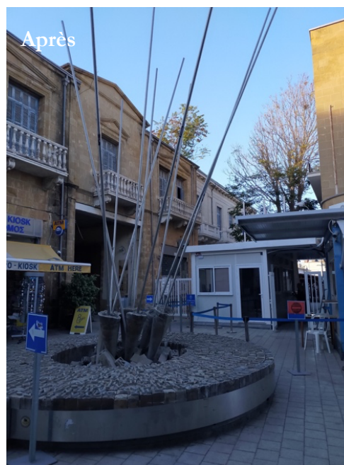
Image 46 Ledra Street CP après la rénovation
