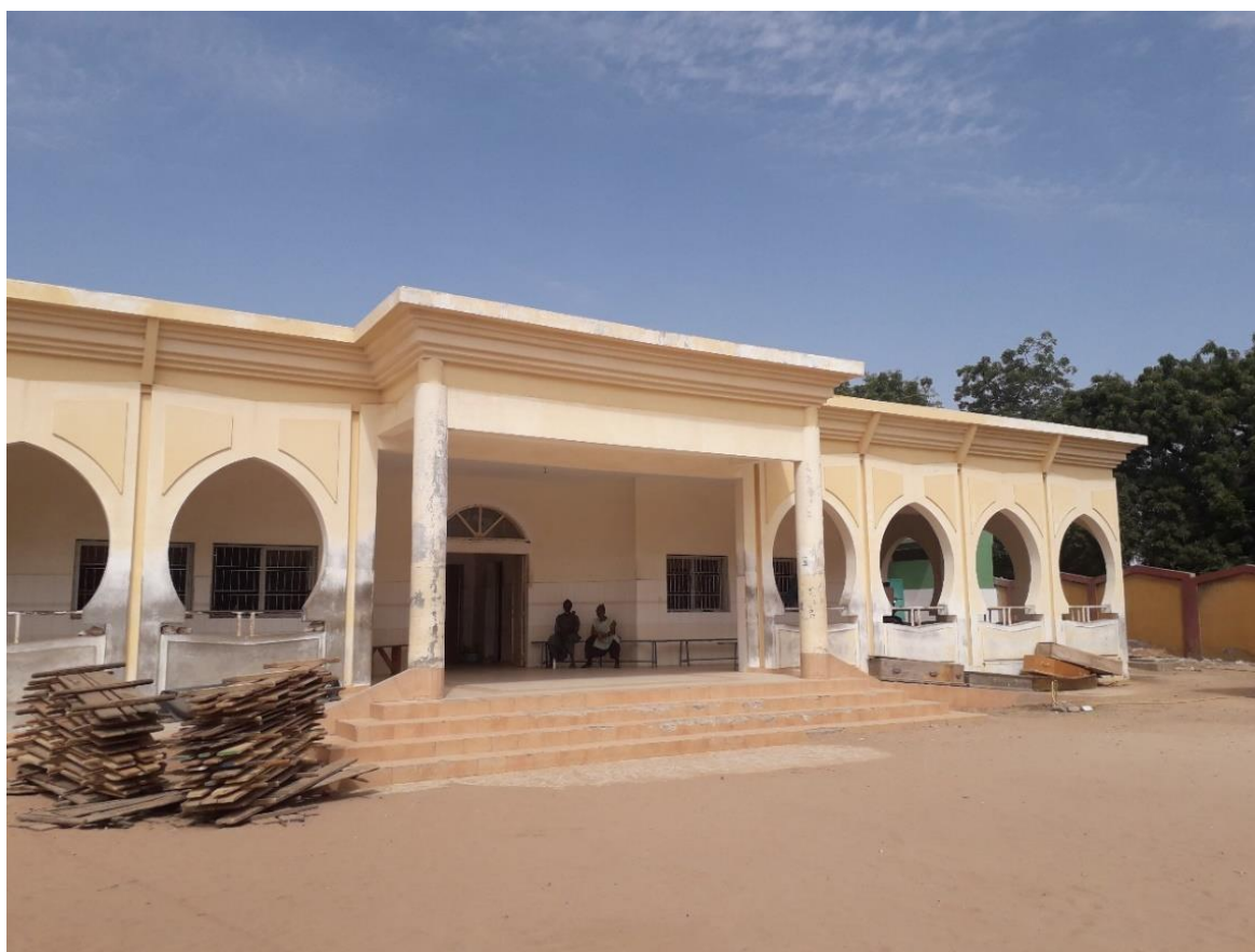
La morgue et le bureau du centre-ville, Touba. Photographie prise par l'auteur, 22/11/19
