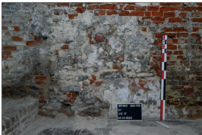
Fig. 18. Vestige de fondation en moellons de calcaire gréseux et briques à matrice hétérogène US17 (secteur 1) (© urban.brussels-ULB)
