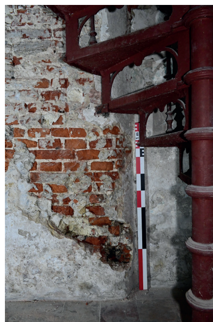
Fig. 15. Vue de la maçonnerie bûchée US15 , liée à l'installation de l'escalier en vis (secteur 1) (© urban.brussels-ULB)
