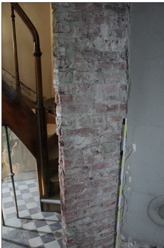
Fig. 42 à 45. Cloison intérieure du premier étage composée de briques réemployées cimentées (US1000). (Cliché A. Baudry © urban.brussels-ULiège)
