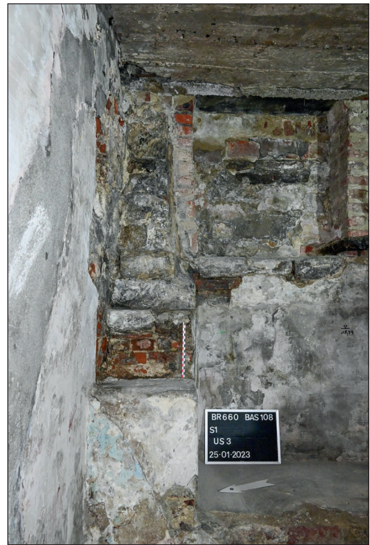
Fig. 7. Détail du piédroit nord en briques et pierres US03 (© urban.brussels-ULB)
