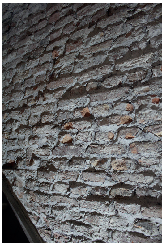
Fig. 60 & 61. Maçonnerie cimentée en briques fin XVIIIe ou début XIXe siècle (?) composant le mur arrière de la bâtisse, observable au quatrième étage. (Cliché A. Baudry © urban.brussels-ULiège)
