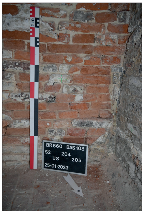
Fig. 29. Détail de la reprise en briquettes noires US205 (secteur 2) (© urban.brussels-ULB)
