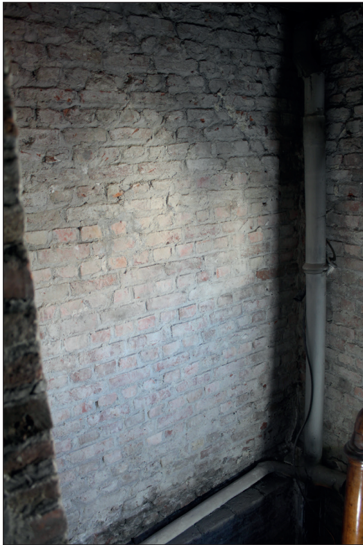
Fig. 65 & 66. Rehaussement du mur-gouttereau sud avec des briques industrielles cimentées en 1917-1918 (US5004). (Cliché A. Baudry © urban.brussels-ULiège)
