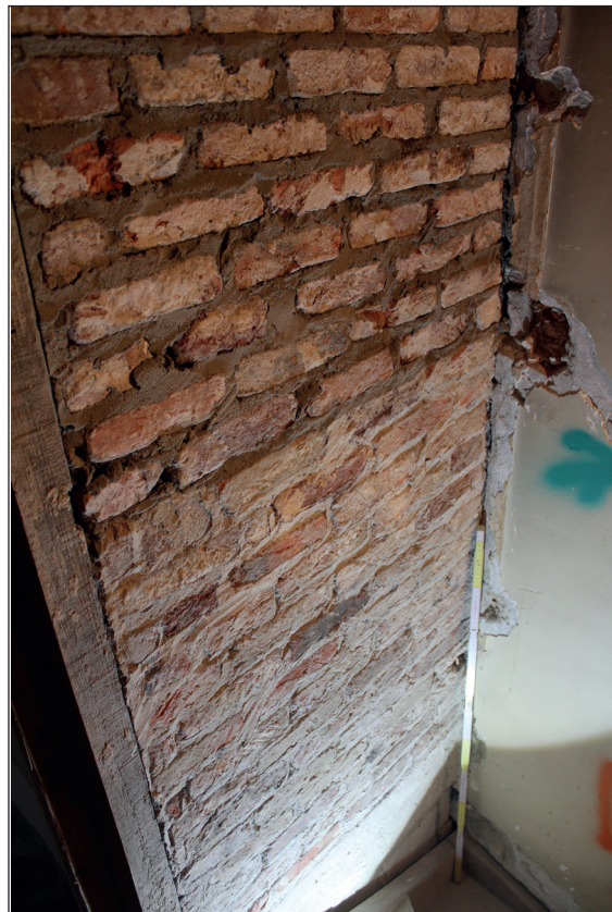
Fig. 42 à 45. Cloison intérieure du premier étage composée de briques réemployées cimentées (US1000). (Cliché A. Baudry © urban.brussels-ULiège)
