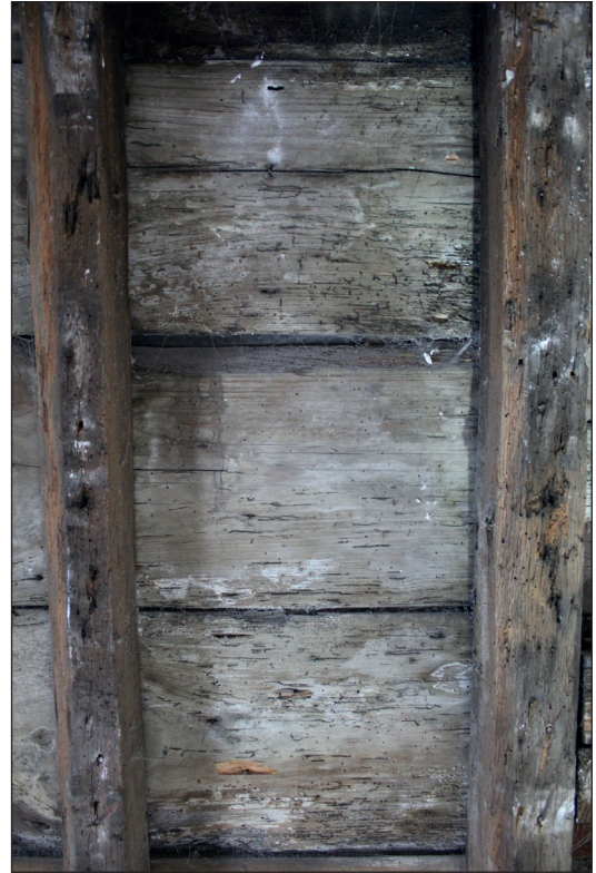
Fig. 69 & 70. Voliges anciennes (US5002) dans les charpentes modernes de la cage d'escalier (US5000). (Cliché A. Baudry © urban.brussels-ULiège)
