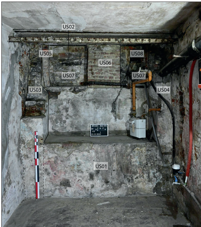
Fig. 6. Photographie générale du mur est de façade en cave (secteur 1) (© urban.brussels-ULB)
