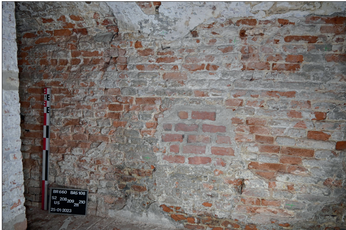
Fig. 35. Vue générale du mur nord en cave (secteur 2) (© urban.brussels-ULB)
