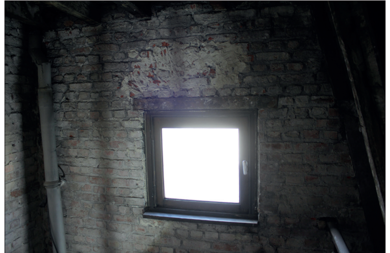
Fig. 65 & 66. Rehaussement du mur-gouttereau sud avec des briques industrielles cimentées en 1917-1918 (US5004). (Cliché A. Baudry © urban.brussels-ULiège)
