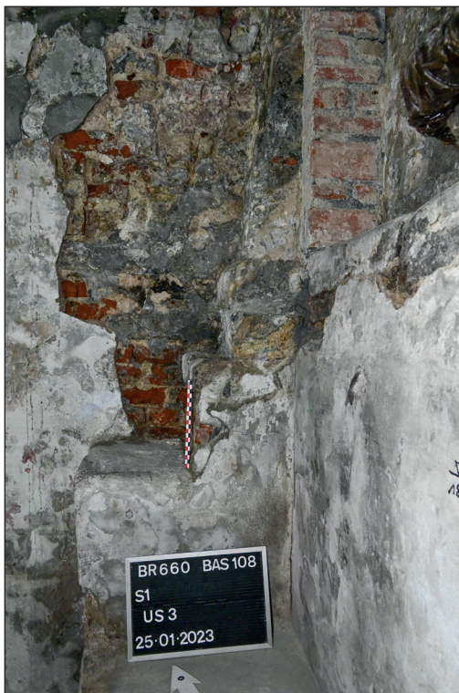
Fig. 8. Profil du piédroit nord en briques et pierres US03 (© urban.brussels-ULB)
