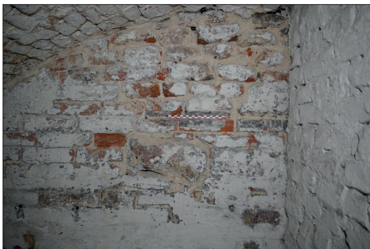
Fig. 32. Détail du moellon de calcaire gréseux (US207) présent dans la maçonnerie US206 (secteur 1) (© urban.brussels-ULB)
