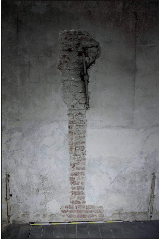
Fig. 56 à 59. Ancres (US4000) au quatrième étage du mur-gouttereau nord. (Cliché A. Baudry © urban.brussels-ULiège)
