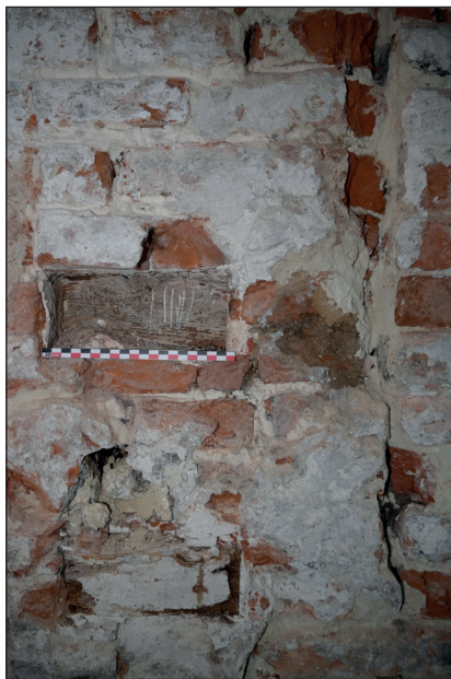
Fig. 28a. Détail d'une pièce en bois (US203) insérée dans l'US202 (secteur 2) (© urban.brussels-ULB)
