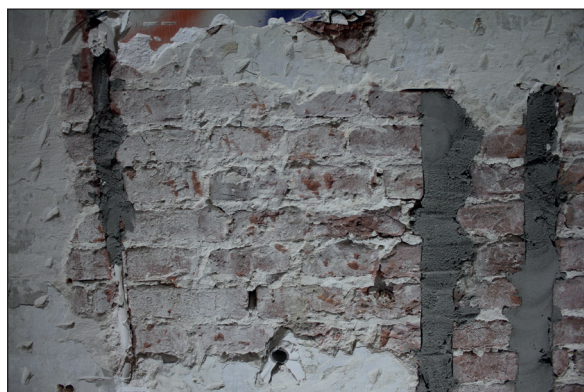
Fig. 47 à 49. Maçonnerie du mur-gouttereau nord, au deuxième étage (US2000). Briques homogènes d'env. 223/237 x 92-108 x 42-48 mm.
