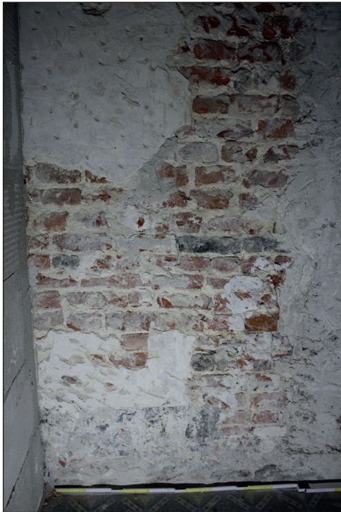
Fig. 50 à 52. Maçonnerie du mur-gouttereau sud, au deuxième étage (US2001), composée majoritairement de briques fragmentaires réemployées. (Cliché A. Baudry © urban.brussels-ULiège)
