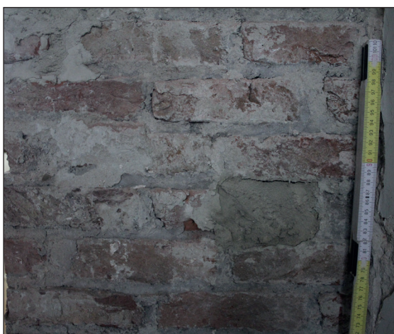
Fig. 42 à 45. Cloison intérieure du premier étage composée de briques réemployées cimentées (US1000). (Cliché A. Baudry © urban.brussels-ULiège)
