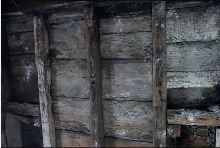
Fig. 69 & 70. Voliges anciennes (US5002) dans les charpentes modernes de la cage d'escalier (US5000). (Cliché A. Baudry © urban.brussels-ULiège)
