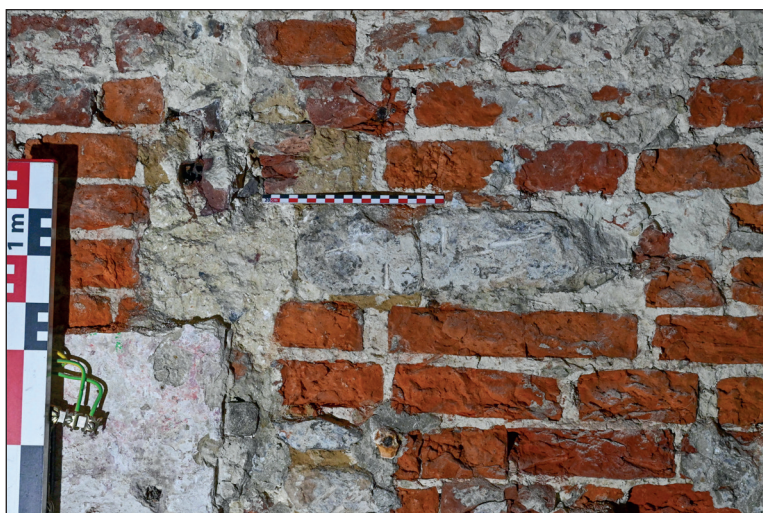
Fig. 14. Détail du moellon de calcaire gréseux US14 présent dans la maçonnerie US10 (secteur 1) © urban.brussels-ULB
