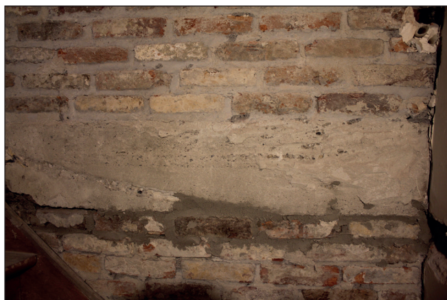
Fig. 46. Cloison intérieure du deuxième étage composée de briques réemployées cimentées et s'appuyant sur les planchers en béton de 1917-1918 (US1000). (Cliché A. Baudry © urban.brussels-ULiège)
