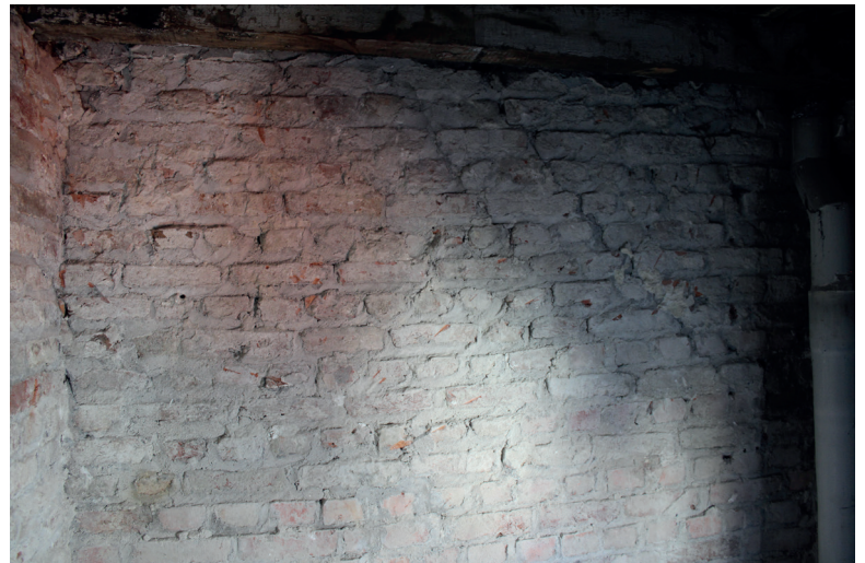
Fig. 68. Rehausse du mur-gouttereau sud avec des briques industrielles cimentées en 1917-1918 (US5004). (Cliché A. Baudry © urban.brussels-ULiège)
