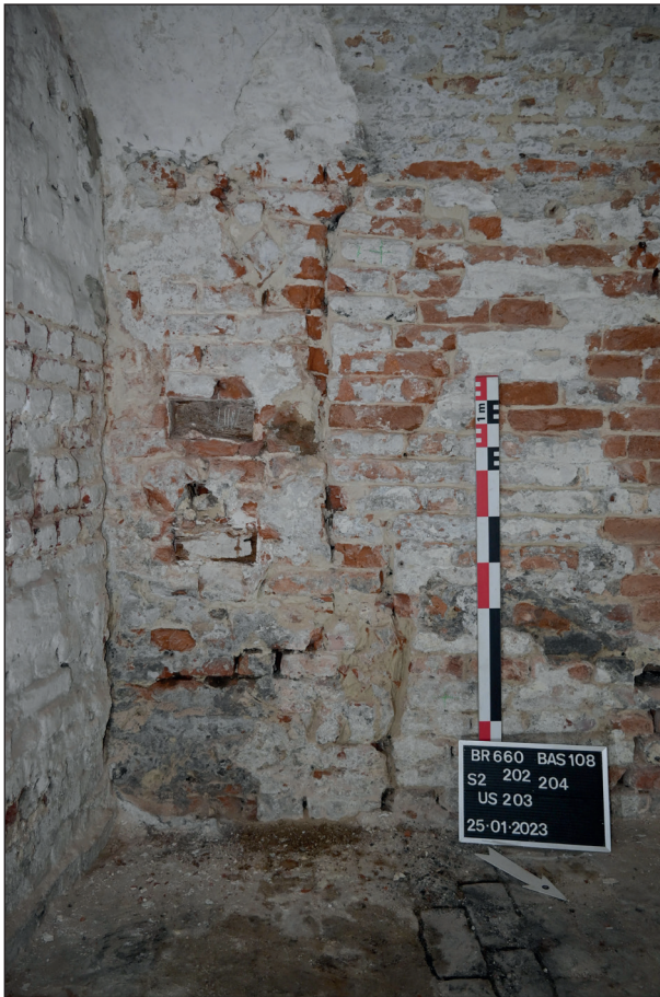
Fig. 27. Vue de la maçonnerie occidentale US202 (secteur 2) (© urban.brussels-ULB)
