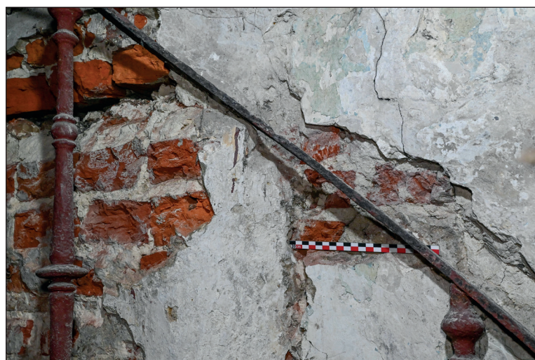
Fig. 16. Détail de la maçonnerie US16 située derrière l'escalier et montrant un léger décalage d'assise (secteur 1) (© urban.brussels-ULB)
