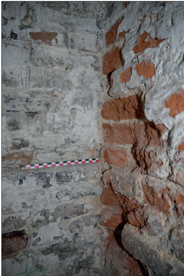
Fig. 34. Détail du harpage entre le massif US208 et le mur nord US209 (secteur 2) (© urban.brussels-ULB)
