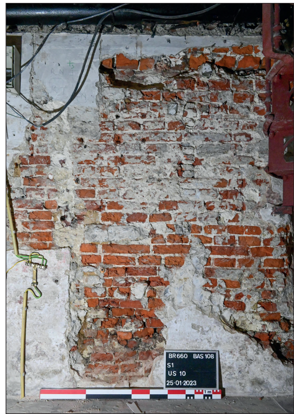
Fig. 11. Vue de la maçonnerie principale US10, observée côté ouest (secteur 1) (© urban.brussels-ULB)
