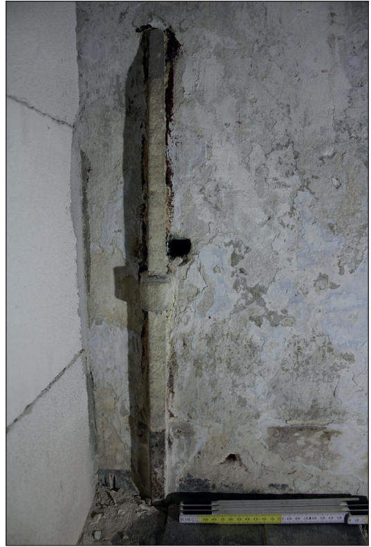
Fig. 56 à 59. Ancres (US4000) au quatrième étage du mur-gouttereau nord. (Cliché A. Baudry © urban.brussels-ULiège)
