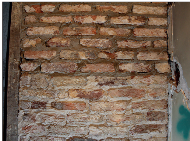
Fig. 42 à 45. Cloison intérieure du premier étage composée de briques réemployées cimentées (US1000). (Cliché A. Baudry © urban.brussels-ULiège)
