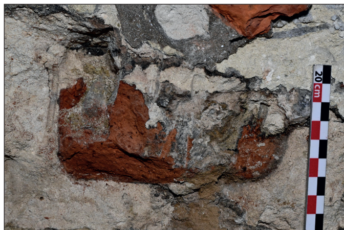
Fig. 19. Détail d'une matrice hétérogène de l'US17 (© urban.brussels-ULB)
