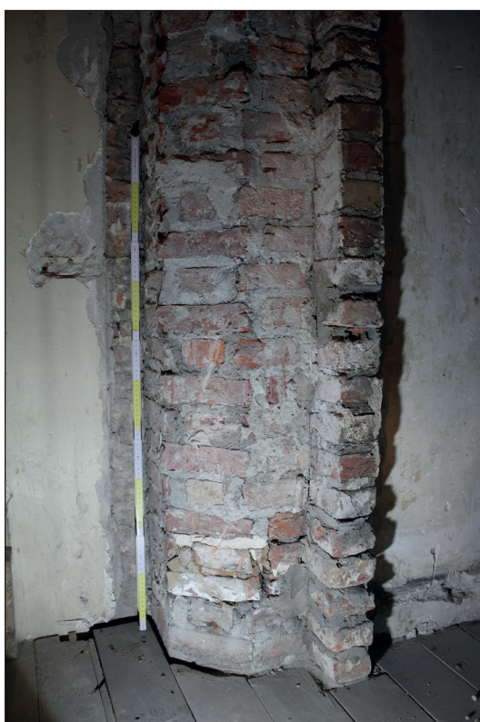
Fig. 55. Gaine de technique en briques réemployées cimentées, au troisième étage, contre le mur-gouttereau nord. (Cliché A. Baudry © urban.brussels-ULiège)
