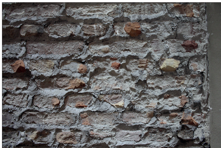
Fig. 60 & 61. Maçonnerie cimentée en briques fin XVIIIe ou début XIXe siècle (?) composant le mur arrière de la bâtisse, observable au quatrième étage. (Cliché A. Baudry © urban.brussels-ULiège)
