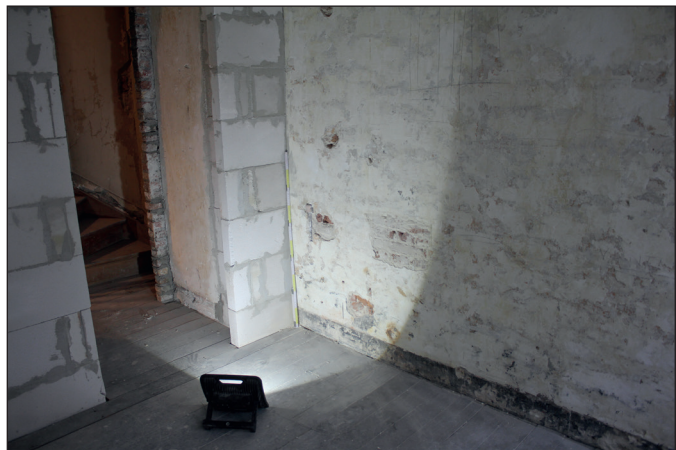
Fig. 53. Vue générale de l'ancre ( US3000 ) noyée dans les maçonneries du mur-gouttereau nord, au troisième étage. (Cliché A. Baudry © urban.brussels-ULiège)
