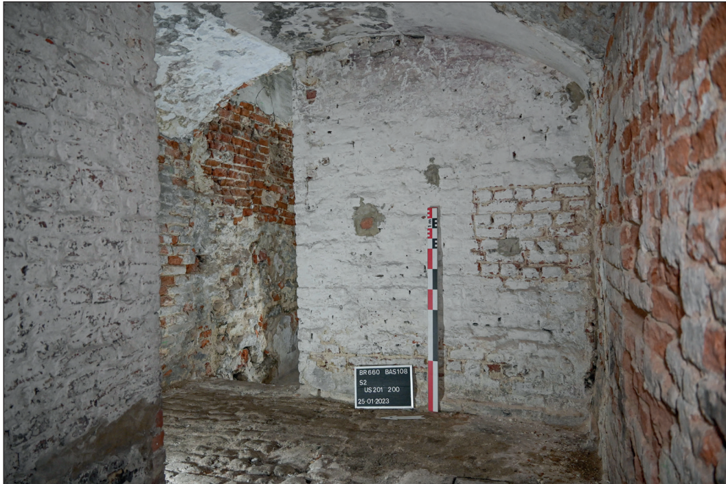
Fig. 25. Vue générale du mur est en cave (secteur 2) (©urban.brussels-ULB)
