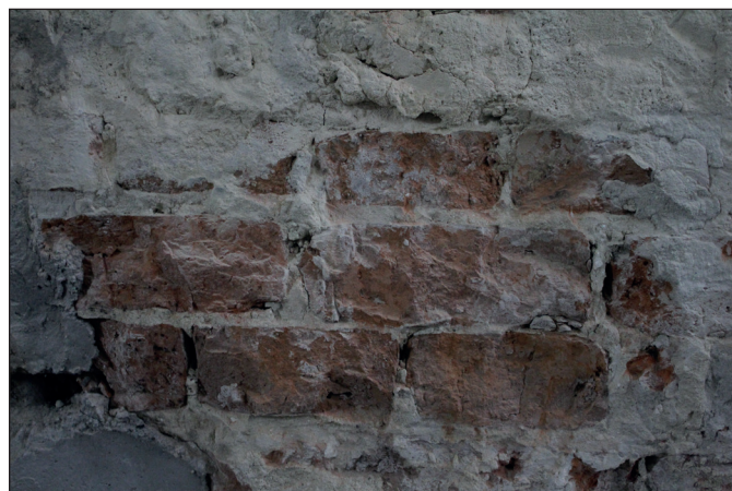
Fig. 39 & 40. Maçonnerie du mur-gouttereau nord, au premier étage (US1001). Briques fragmentaires et de gabarits hétérogènes. (Cliché A. Baudry © urban.brussels-ULiège)
