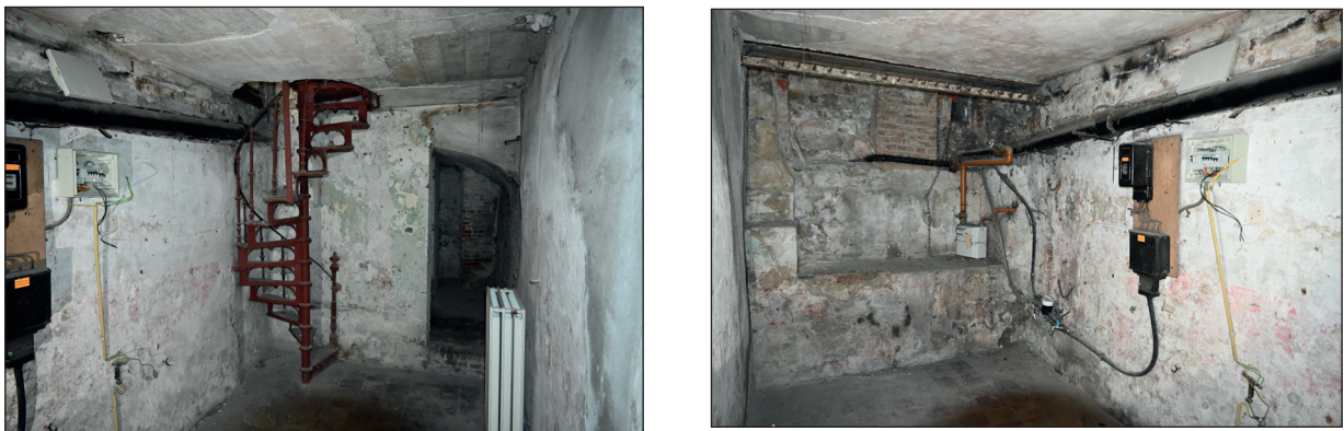
Fig. 1 & 2. Photographies des espaces de cave avant décapage des maçonneries (© urban.brussels-ULB)
