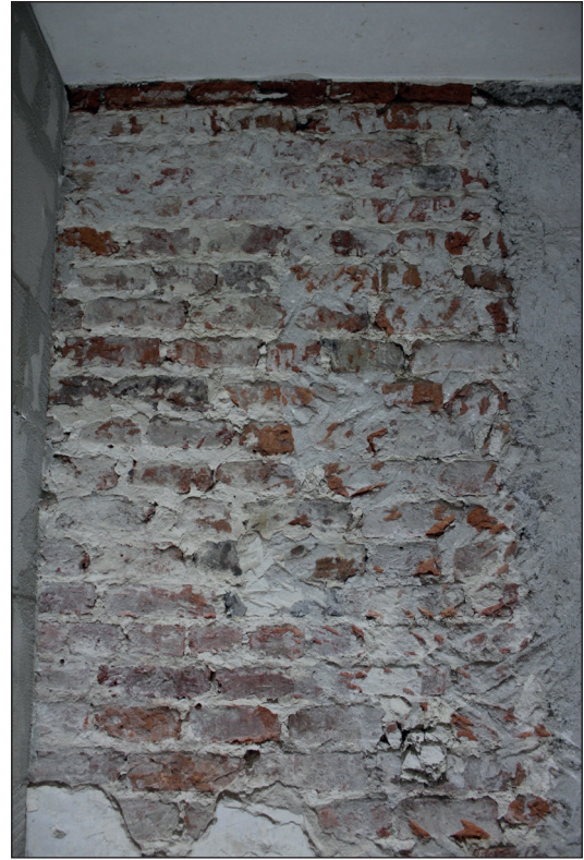
Fig. 50 à 52. Maçonnerie du mur-gouttereau sud, au deuxième étage (US2001), composée majoritairement de briques fragmentaires réemployées. (Cliché A. Baudry © urban.brussels-ULiège)
