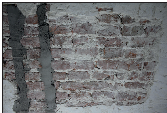
Fig. 47 à 49. Maçonnerie du mur-gouttereau nord, au deuxième étage (US2000). Briques homogènes d'env. 223/237 x 92-108 x 42-48 mm.
