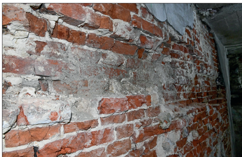
Fig. 22-23. Détail du retrait de maçonnerie sur deux assises du mur nord (secteur 1) (© urban.brussels-ULB)
