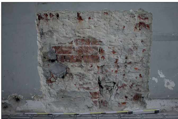
Fig. 39 & 40. Maçonnerie du mur-gouttereau nord, au premier étage (US1001). Briques fragmentaires et de gabarits hétérogènes. (Cliché A. Baudry © urban.brussels-ULiège)
