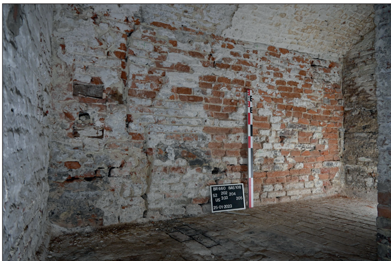
Fig. 26. Vue générale du mur sud en cave avec indications des US (secteur 2) (©urban.brussels-ULB)
