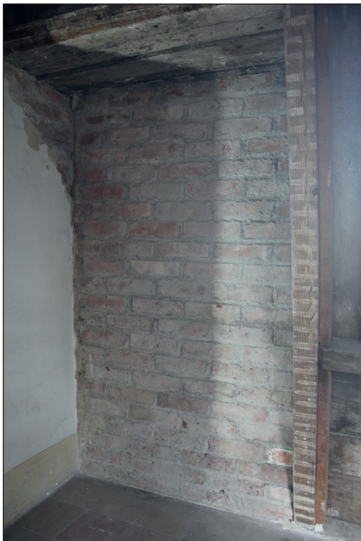
Fig. 67. Coffre de cheminée en briques industrielles cimentées (US5004). Cliché A. Baudry, 17 janvier 2023 © urban.brussels-ULiège
