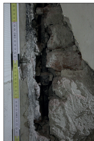
Fig. 41. Ancre (US1002) noyée dans les maçonneries du mur-gouttereau sud, au premier étage. (Cliché A. Baudry © urban.brussels-ULiège)
