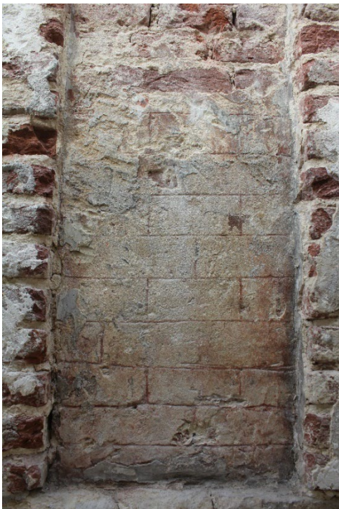
Fig. 29 : enduit rouge primitif arborant un faux appareil de briques. Photo : Antoine Baudry. © urban.brussels-ULiège.
