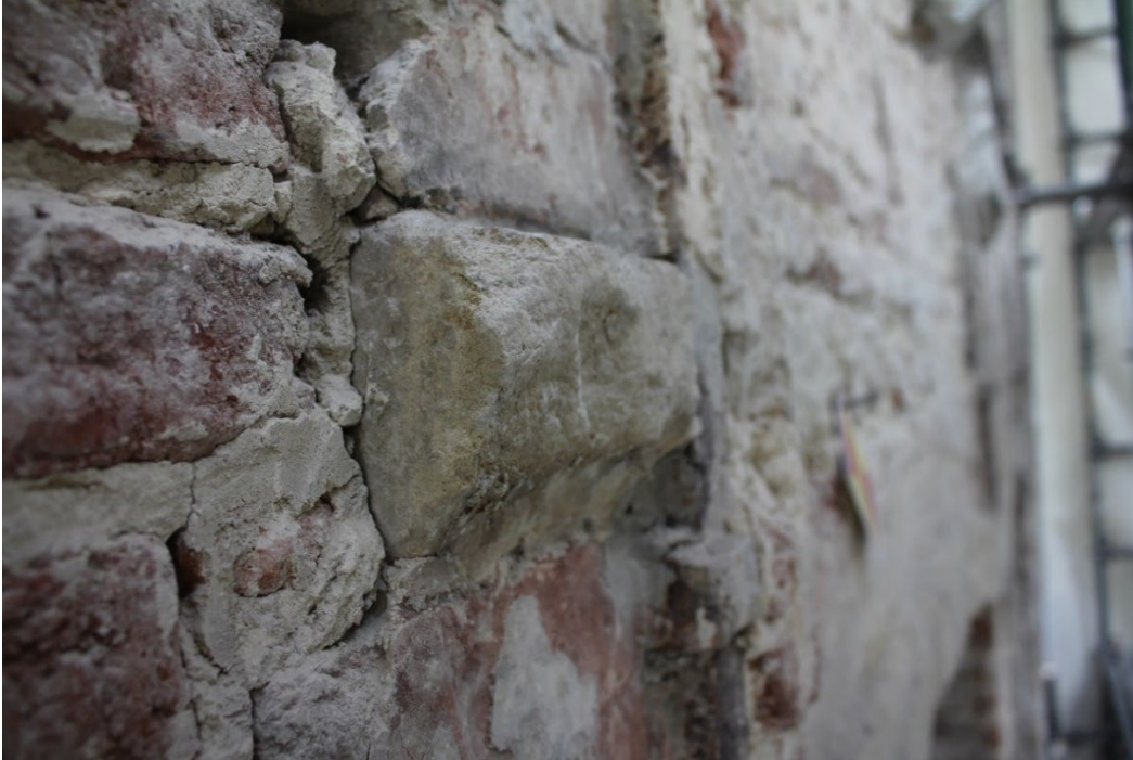
Fig. 17 : fragment d'un bloc du cordon mouluré du premier étage préservé. On y distingue un cavet (en bas), un réglet (au centre), et le retour de ce dernier est ou bien droit, ou bien légèrement biseauté, ou bien légèrement concave (vestiges insuffisants). Photo : Antoine Baudry. © urban.brussels-ULiège.
