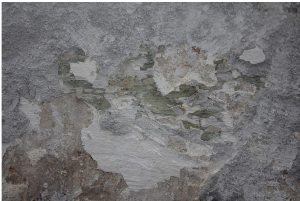
Fig. 33 : enduits présents sur l'intrados des arcs des fenêtres du premier étage. Photo : Antoine Baudry. © urban.brussels-ULiège.
