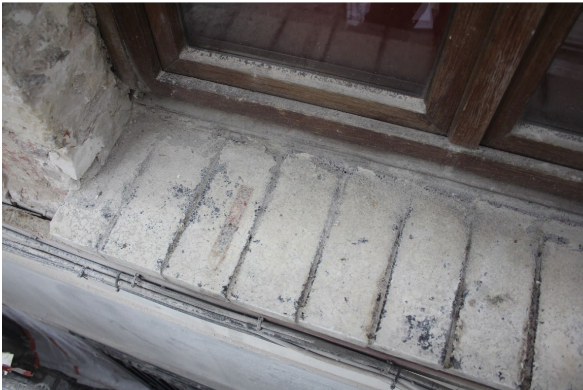
Fig. 10 : un des appuis des fenêtres du premier étage en briques vernissées. Photo : Antoine Baudry. © urban.brussels-ULiège.
