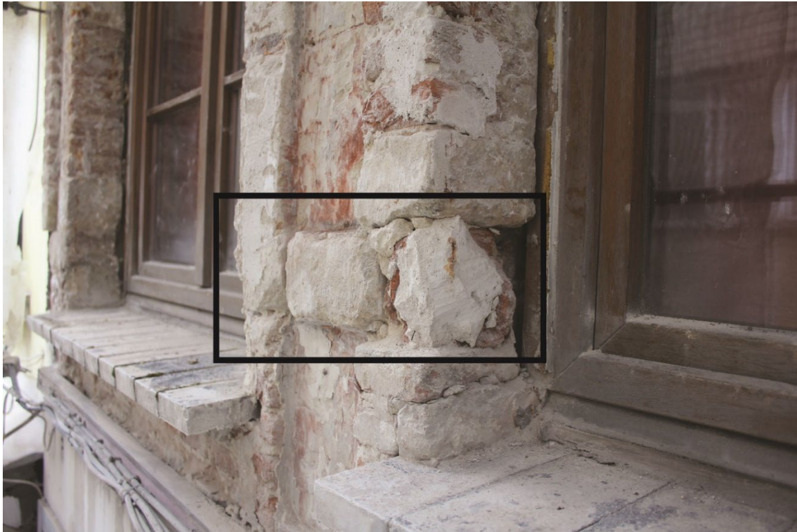
Fig. 7 : localisation du niveau des appuis primitifs des fenêtres du premier étage. Photo : Antoine Baudry. © urban.brussels-ULiège.
