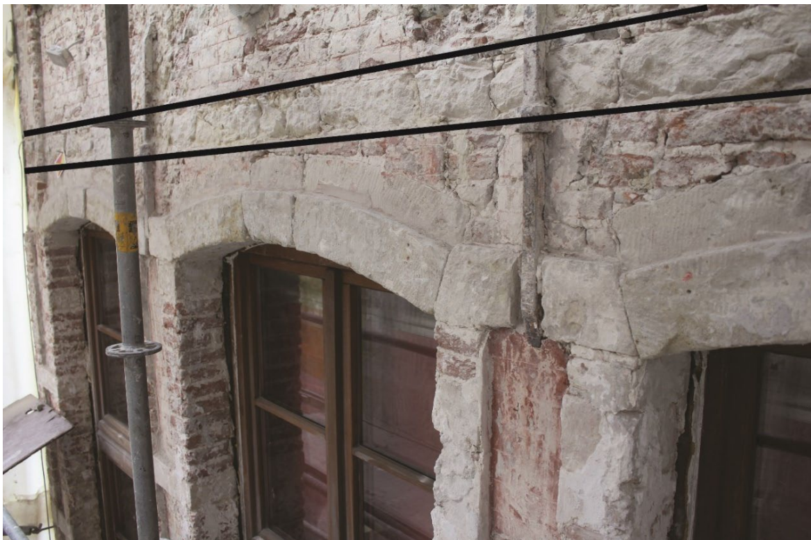
Fig. 16 : on distingue, au-dessus des arcs surbaissés des fenêtres du premier étage, les pierres de l'ancien cordon mouluré aujourd'hui ravalé. Photo : Antoine Baudry. © urban.brussels-ULiège.
