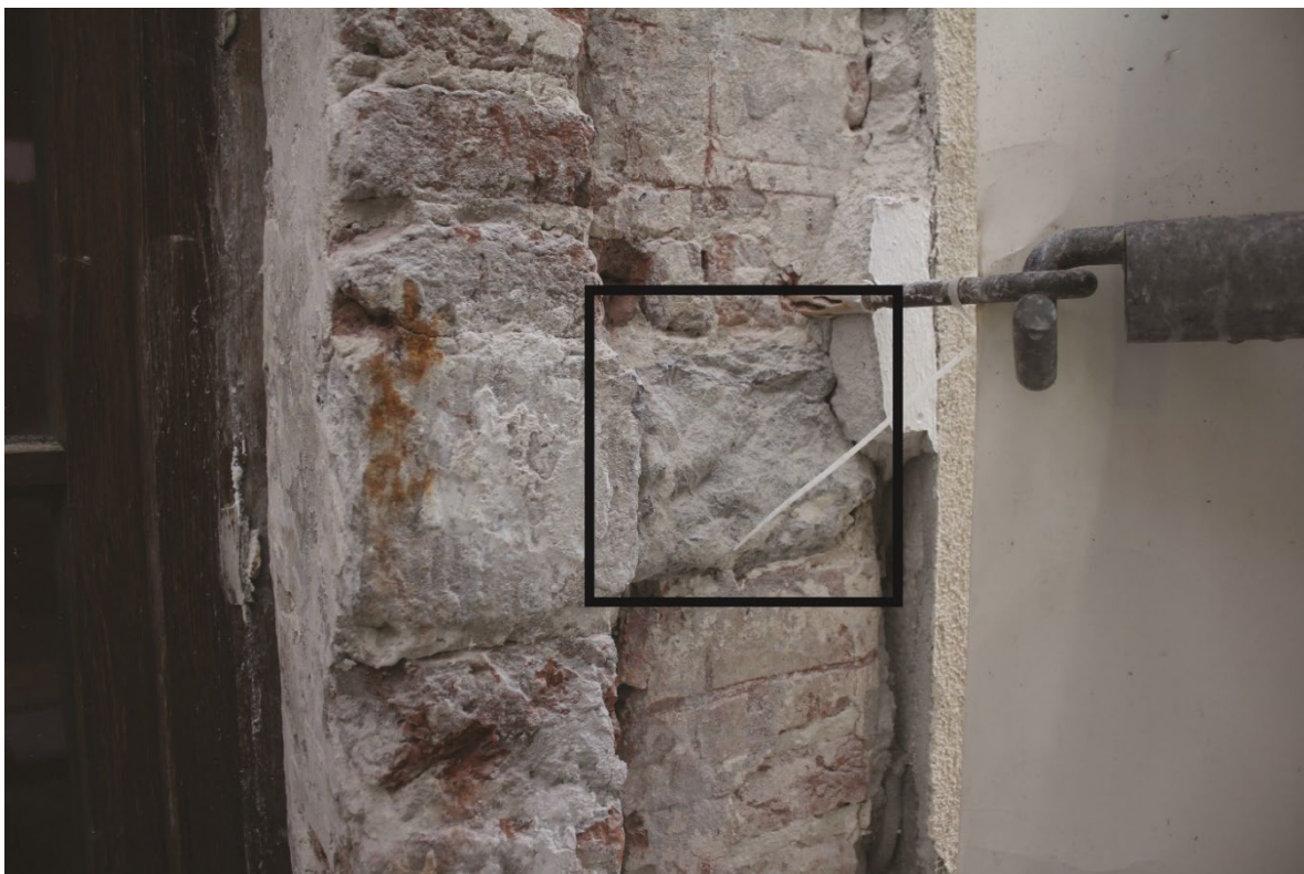
Fig. 12 : pierre blanche formant cordon en bandeau à l'origine, dont la moitié droite, auparavant saillante (comme à gauche) a été ravalée. Photo : Antoine Baudry. © urban.brussels-ULiège.
