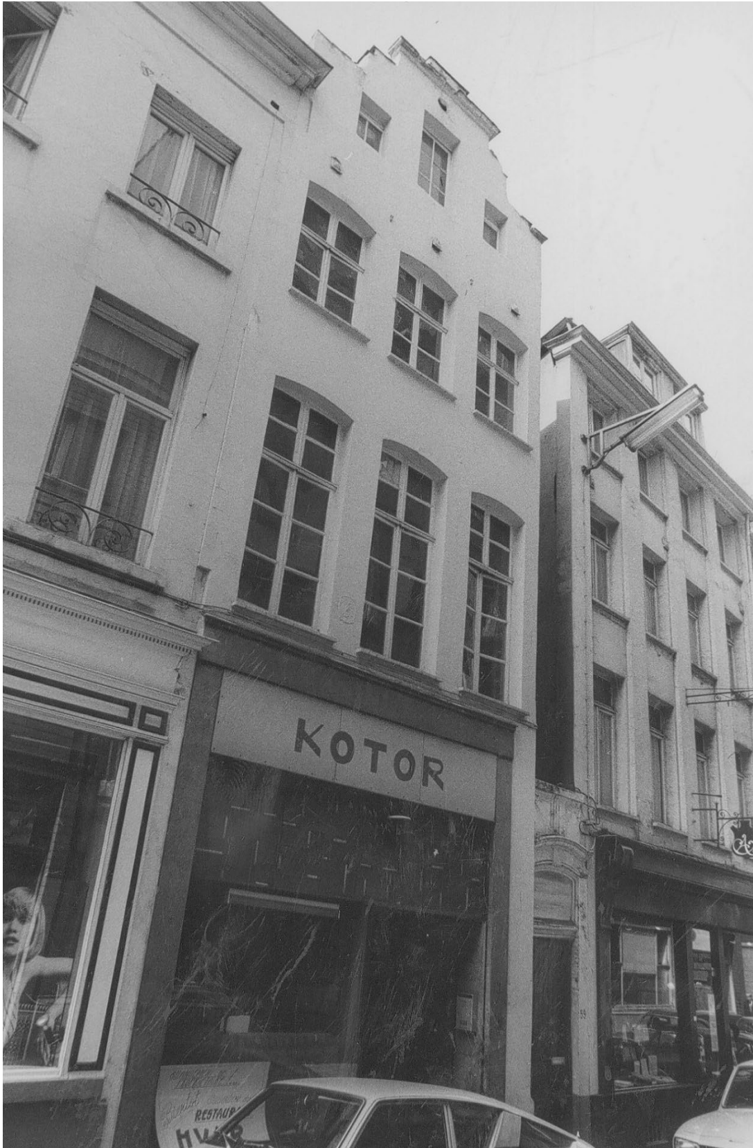
Fig. 6 : la façade en 1975. © KIK-IRPA, cliché t017687.
