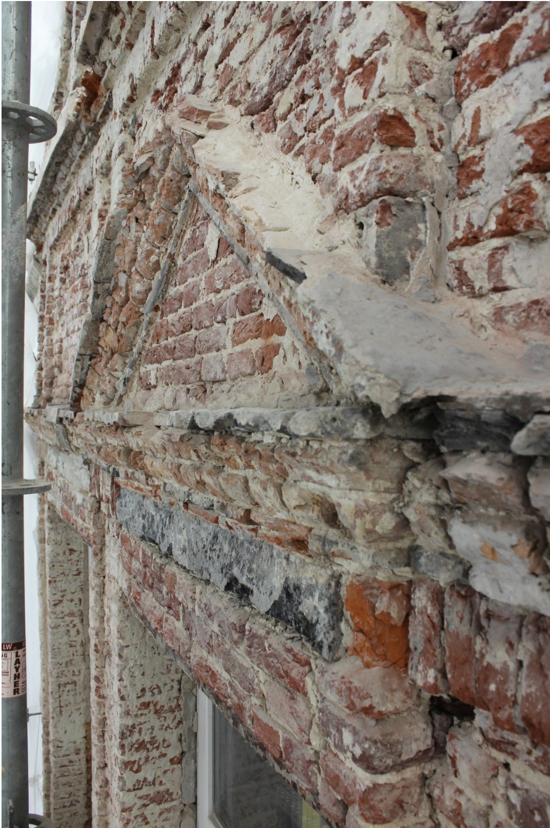
Fig. 21 : fronton triangulaire de la fenêtre axiale du premier étage de la façade située rue du marché aux herbes n°84 (BR639). Photographie : Antoine Baudry. © urban.brussels-ULiège.
