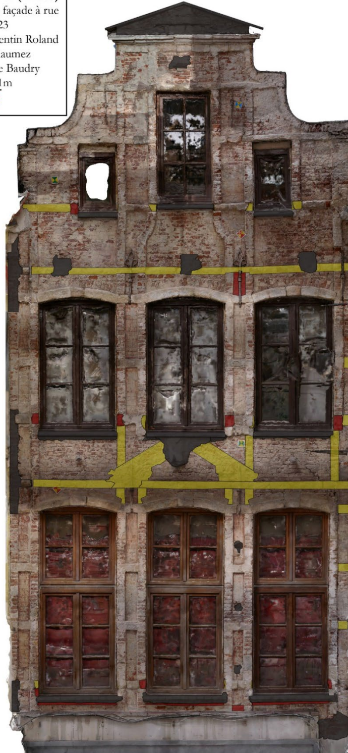
Fig. 3 : Orthophotographie de la façade à rue avec indication des principales modifications.
