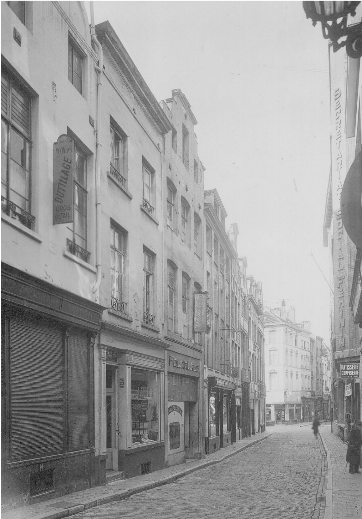
Fig. 5 : la façade en 1944. © KIK-IRPA, cliché A068590.
