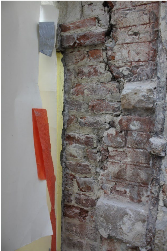
Fig. 15 : à gauche, réfection maçonnée d'une jambe saillante ravalée (ici, angle gauche du bâtiment). à droite, une maçonnerie primitive enduite d'un faux appareil de briques rouges. Photo : Antoine Baudry. © urban.brussels-ULiège.
