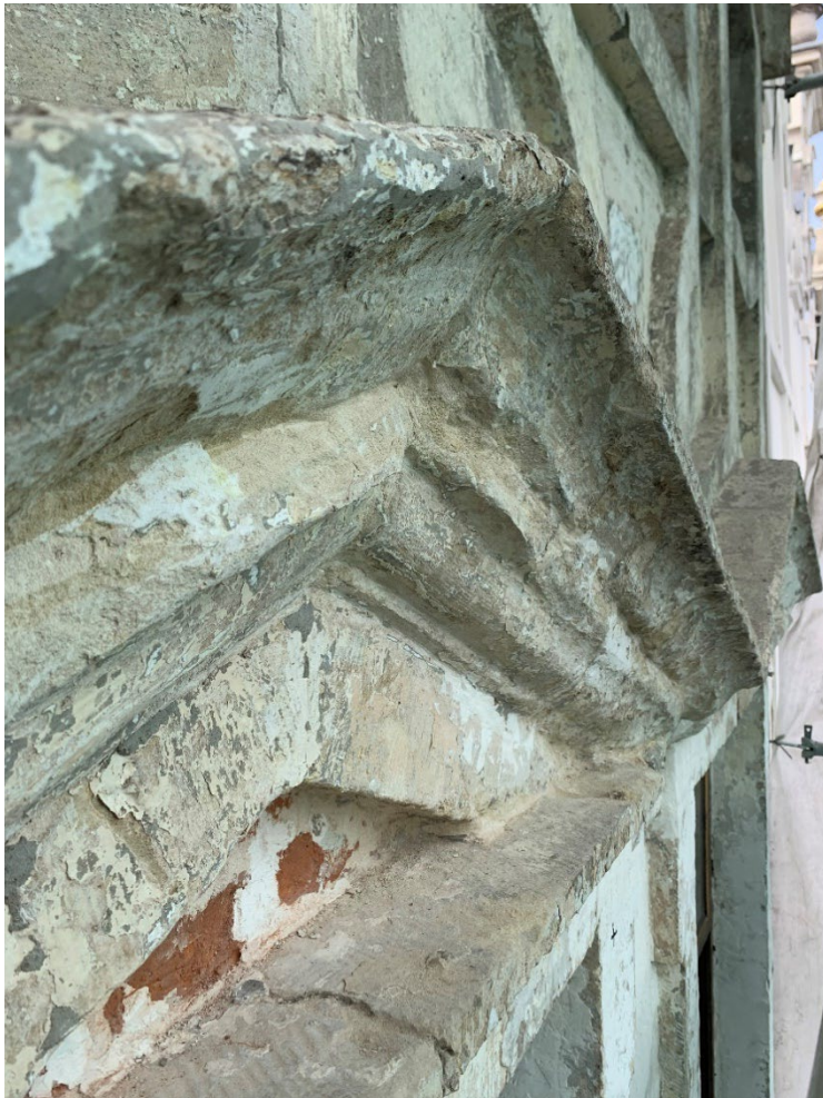
Fig. 23 : détail d'un des frontons triangulaires de la façade située rue du marché aux herbes n°101-103. Photographie Sylvianne Modrie. Source interne : BR769_20230926_119_SMo.
