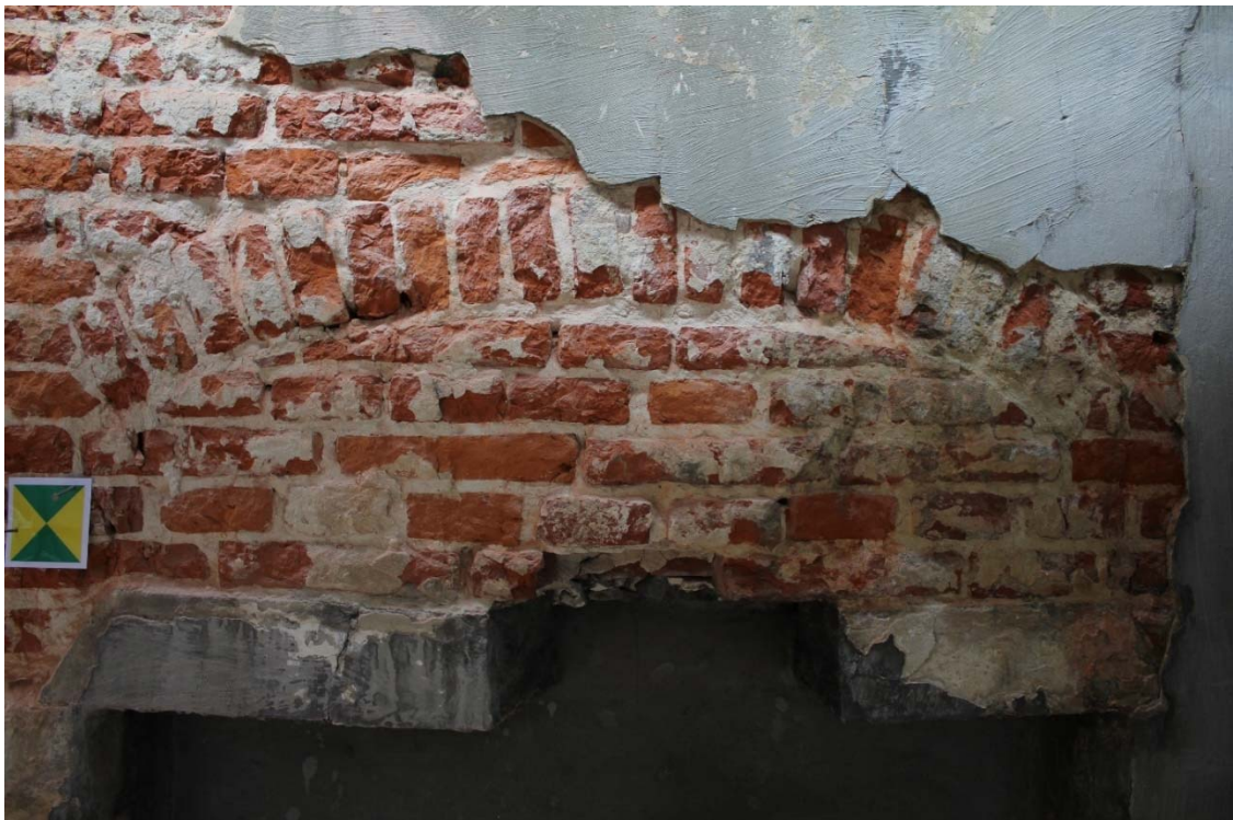
Fig. 16 : arc de décharge et linteau de la baie n°3 (ancienne porte). Photographie : A. Baudry. © urban.brussels-ULiège.
