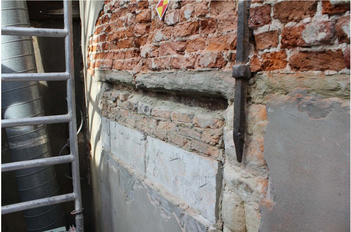
Fig. 13 : ancre US13 de l'étage entre les baies n°4-5. Photographie : A. Baudry. © urban.brussels-ULiège.
