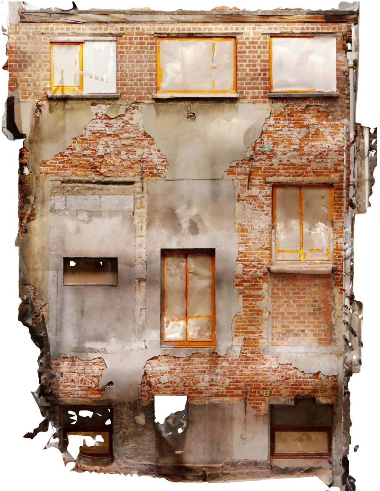
Fig. 5 : orthophotographie de la façade sur cour, 19 octobre 2022 (D. Willaumez). © urban.brussels-ULiège.
