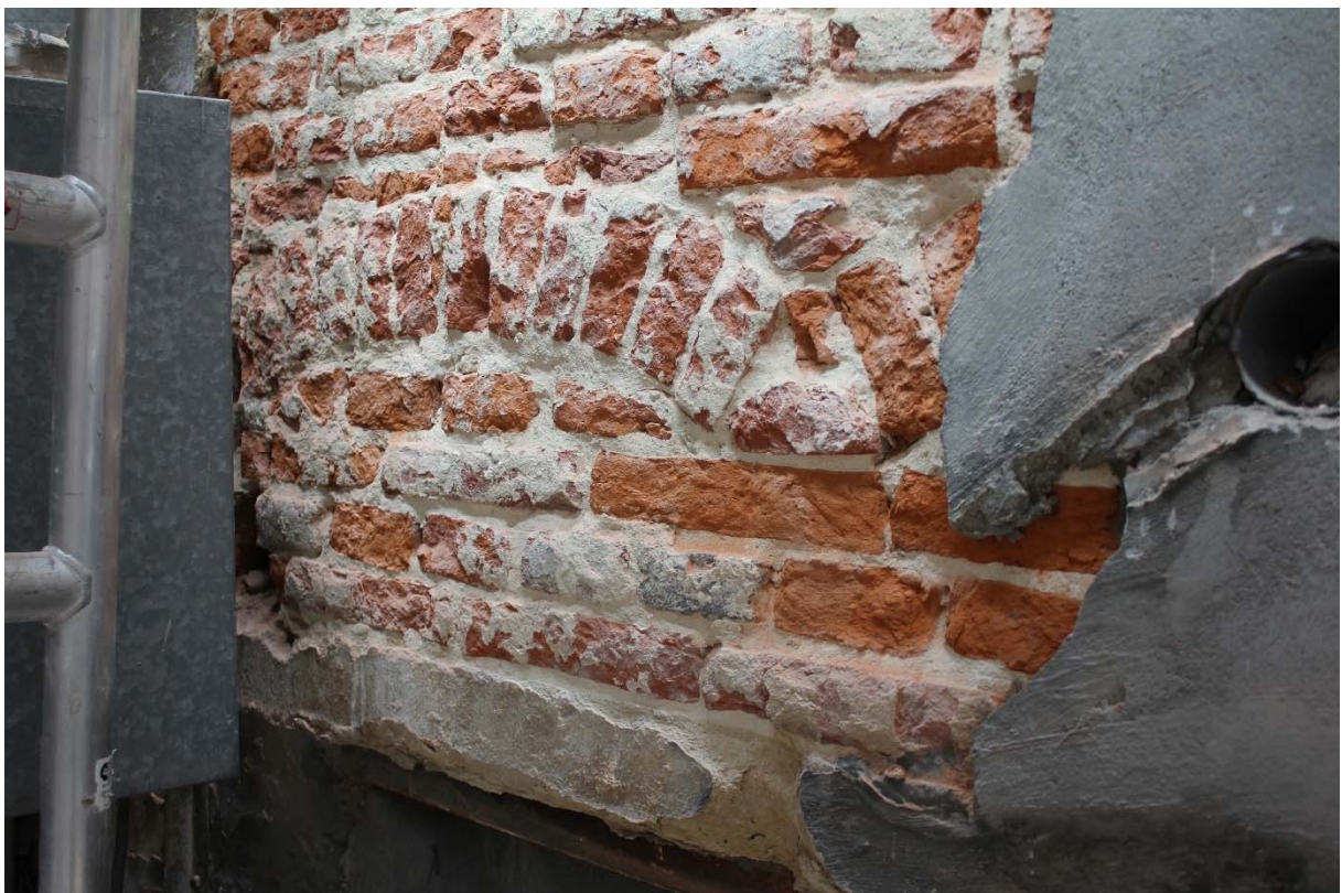
Fig. 14 : arcs de décharge et linteau de la baie n°1. Photographie : A. Baudry. © urban.brussels-ULiège.
