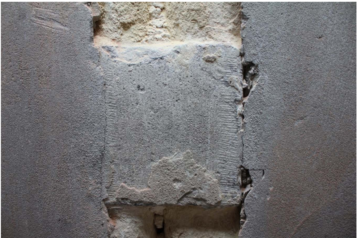
Fig. 18 : détail d'une pierre bleue. Taille au ciseau avec palette de 3,5 cm aux coups légèrement obliques. Photographie : A. Baudry. © urban.brussels-ULiège.
