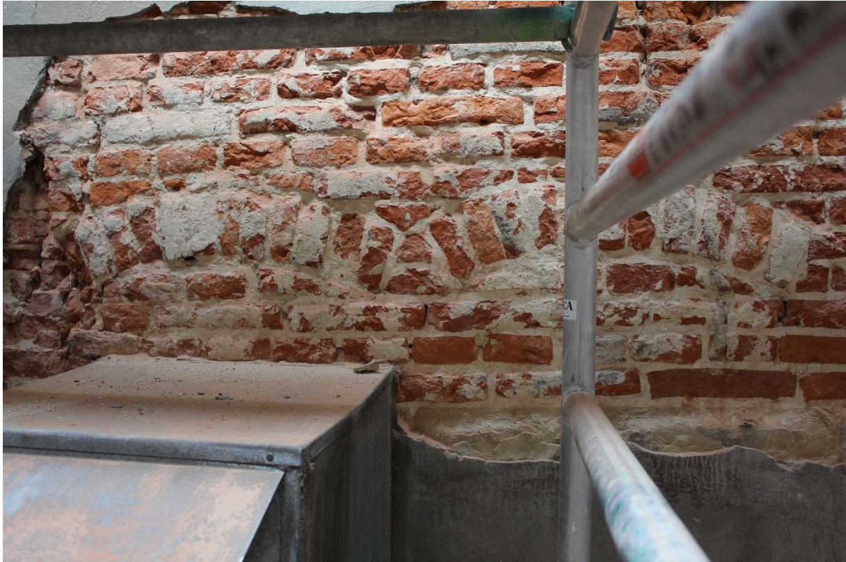
Fig. 15 : arcs de décharge et linteau de la baie n°2. Photographie : A. Baudry. © urban.brussels-ULiège.
