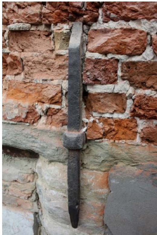
Fig. 12 : ancre US13 de l'étage entre les baies n°4-5. Photographie : A. Baudry. © urban.brussels-ULiège.
