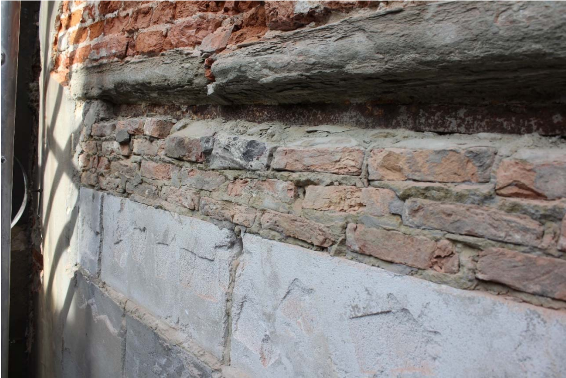
Fig. 7 : comblement de la baie n°4 en blocs Ytong et briques d'Ijssel (US4). Photographie : A. Baudry. © urban.brussels-ULiège.
