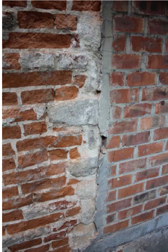
Fig. 19 : piédroit ouest de la baie n°6 en pierres blanches de petits formats. Photographie : A. Baudry. © urban.brussels-ULiège.
