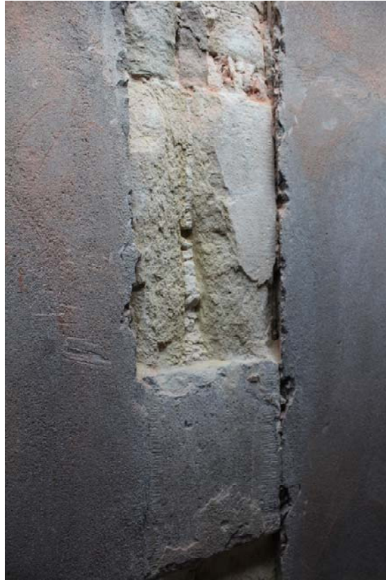
Fig. 17 : alternance des pierres bleues et blanches dans le trumeau des baies n°4-5. Photographie : A. Baudry. © urban.brussels-ULiège.
