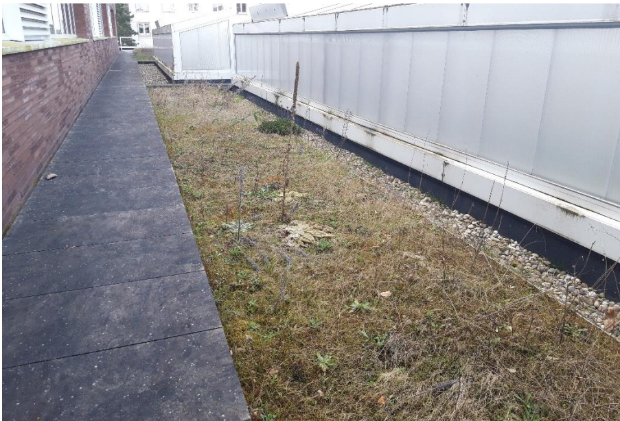
Figure 7-2 : Illustration de la toiture in situ en hiver (février 2022)
