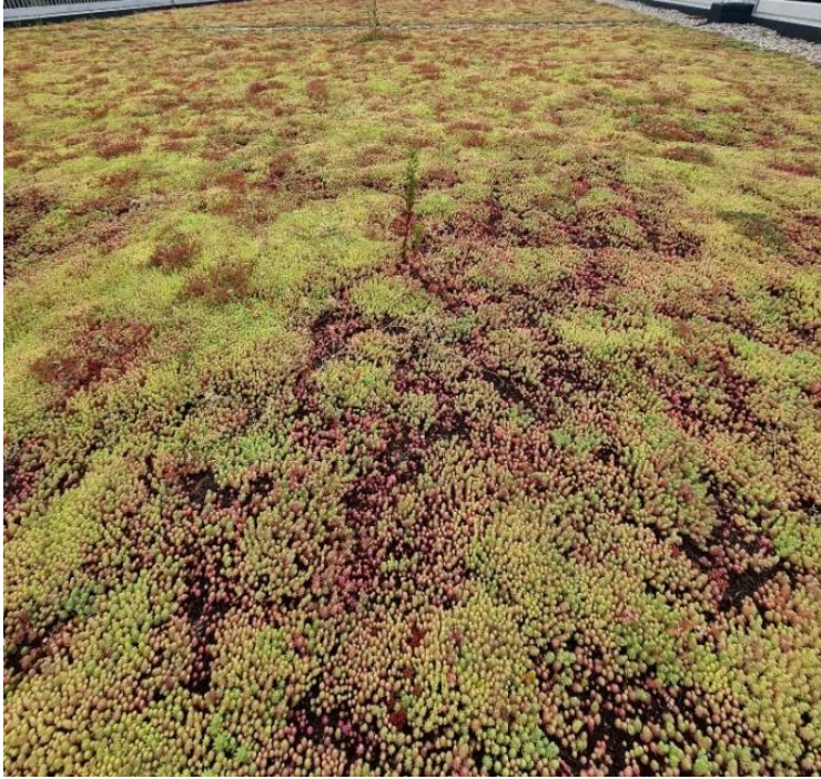
Figure 1-4 : Toiture verte extensive de sedum exotique (Liège, Belgique)
