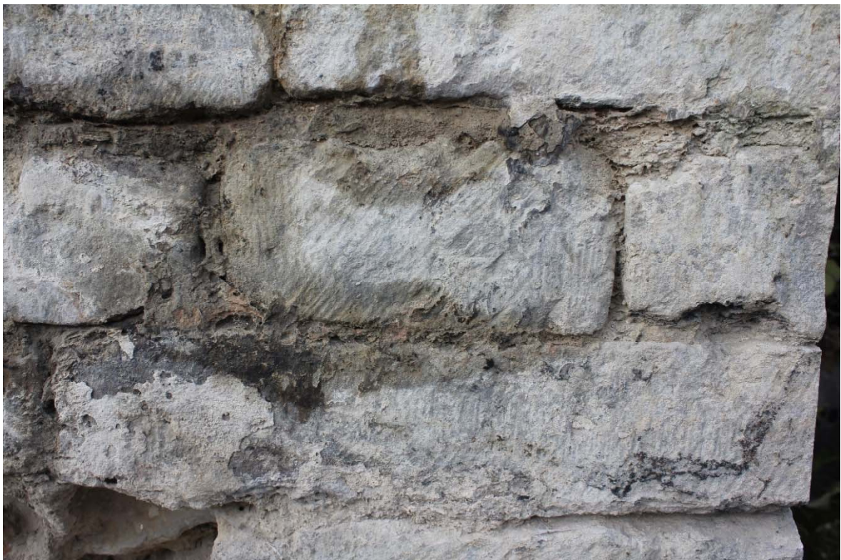
Fig. 18 : parement des moellons à tête dressée mêlant taille fine perpendiculaire serrée (en bas) et taille oblique moins soignée (au centre) ; bloc n°9. Photographie : Antoine Baudry (BR346_20220929_034_ABaudry). © urban.brussels-ULiège.
