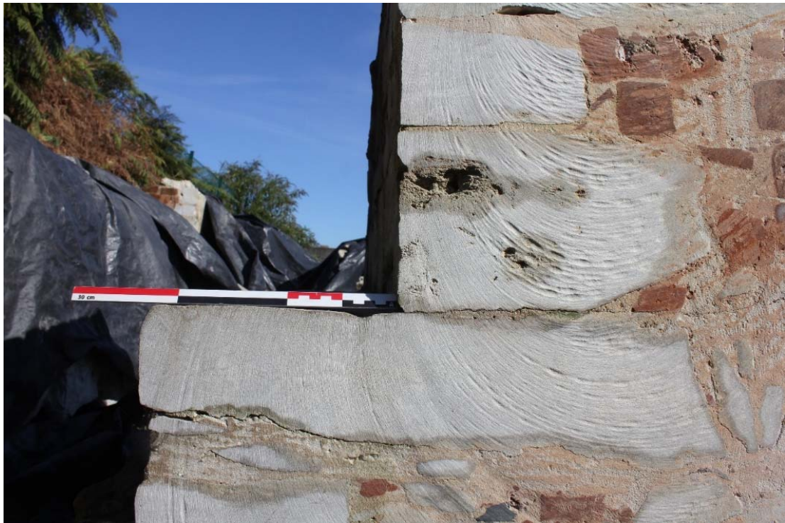
Fig. 7 : coupe des moellons à têtes dressées et des marches aux queues démaigries et faces non apparentes taillées grossièrement, fourrure garnie de briques fragmentaires (bloc n°6). Photographie : Antoine Baudry (BR346_20220929_010_ABaudry). © urban.brussels-ULiège.
