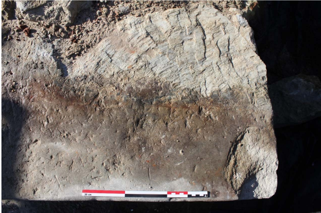
Fig. 9 : en bas, giron érodé d'une marche ; en haut, face d'attente de la marche taillée grossièrement au marteau taillant ou à la polka (bloc n°5). Photographie : Antoine Baudry (BR346_20220929_006_ABaudry). © urban.brussels-ULiège.
