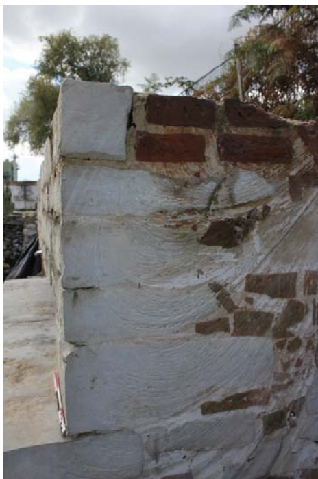
Fig. 2 : coupe des moellons à têtes dressées aux queues démaigries, fourrure garnie de briques fragmentaires (bloc n°9). Photographie : Antoine Baudry (BR346_20220929_036_ABaudry). © urban.brussels-ULiège.
