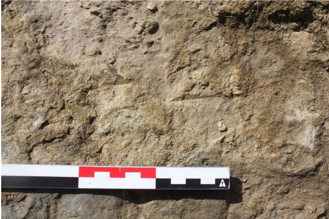
Fig. 25 : face d'attente d'un moellon à tête dressée. Impacts de tranchant droit, polka ou marteau taillant (bloc n°6). Photographie : Antoine Baudry (BR346_20220929_027_ABaudry). © urban.brussels-ULiège.
