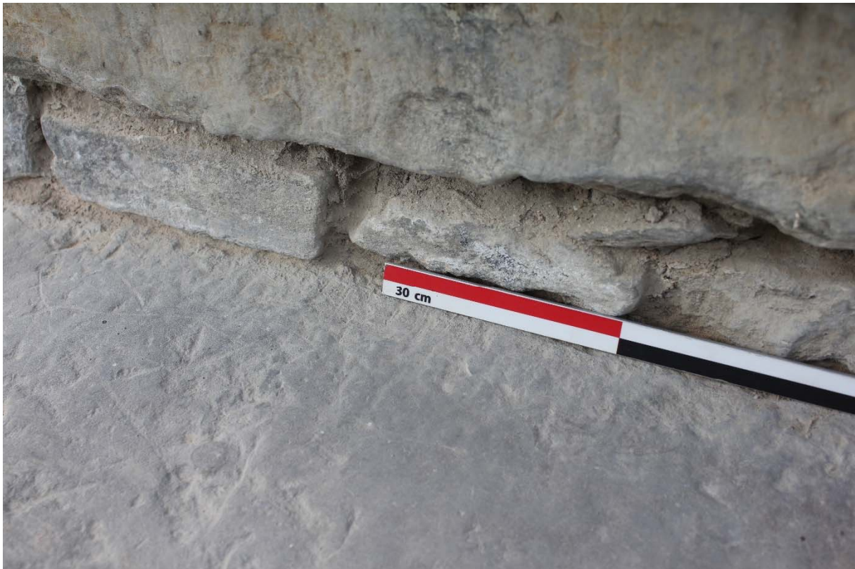
Fig. 14 : éventuelles traces de taillant droit (marteau taillant, polka, charrue ou ciseau) sur le giron d'une des marches (bloc n°9). Photographie : Antoine Baudry (BR346_20220929_032_ABaudry). © urban.brussels-ULiège.
