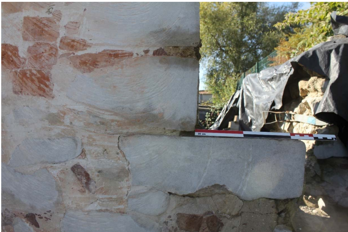
Fig. 8 : coupe des moellons à têtes dressées et des marches aux queues démaigries et faces non apparentes taillées grossièrement, fourrure garnie de briques fragmentaires (bloc n°6). Photographie : Antoine Baudry (BR346_20220929_012_ABaudry). © urban.brussels-ULiège.
