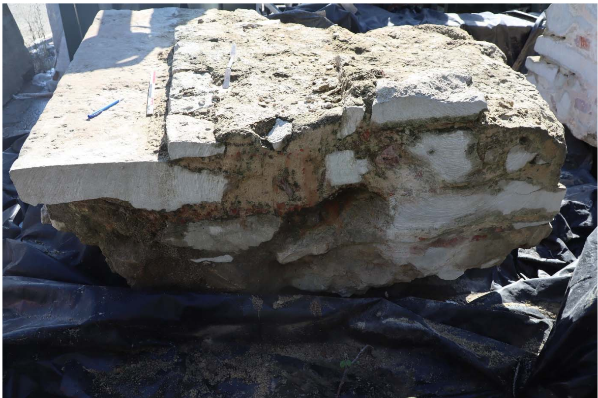
Fig. 12 : à gauche, on observe la face de pose et la queue d'une marche, parties non travaillées (bloc n°4). Photographie : Valérie Ghesquière. © urban.brussels.
