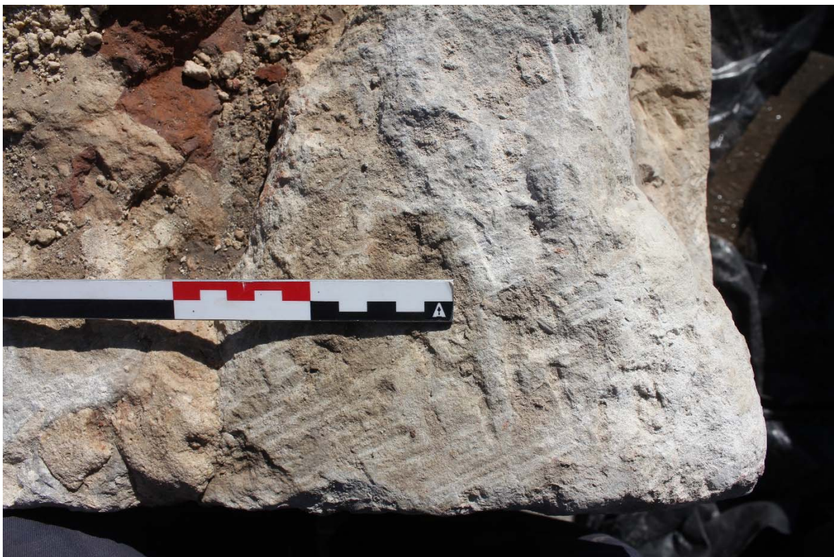
Fig. 24 : face d'attente d'un moellon à tête dressée. Impacts de tranchant droit, polka ou marteau taillant (bloc n°6). Photographie : Antoine Baudry (BR346_20220929_018_ABaudry). © urban.brussels-ULiège.
