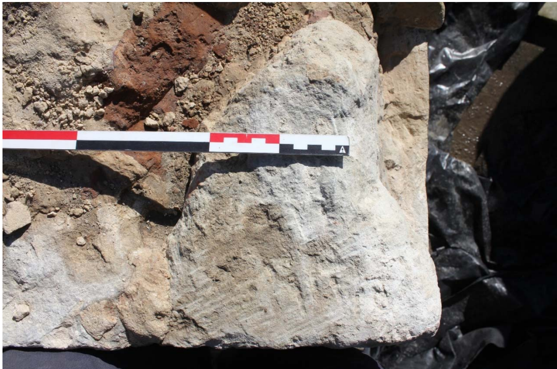
Fig. 10 : face d'attente d'un moellon à tête dressée. Impacts de tranchant droit percuté, polka ou marteau taillant (bloc n°6). Photographie : Antoine Baudry (BR346_20220929_017_ABaudry). © Urban.Brussels-ULiège.
