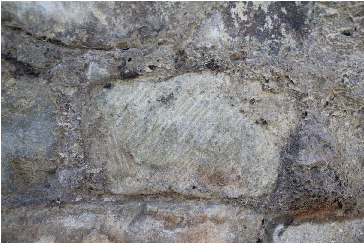
Fig. 20 : impacts obliques d'un tranchant droit (bloc n°9). Photographie : Antoine Baudry (BR346_20220929_015_ABaudry). © urban.brussels-ULiège.
