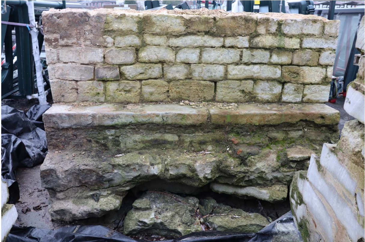
Fig. 5 : vue générale du parement du mur de quai (bloc n°7). Photographie : Valérie Ghesquière. © urban.brussels.
