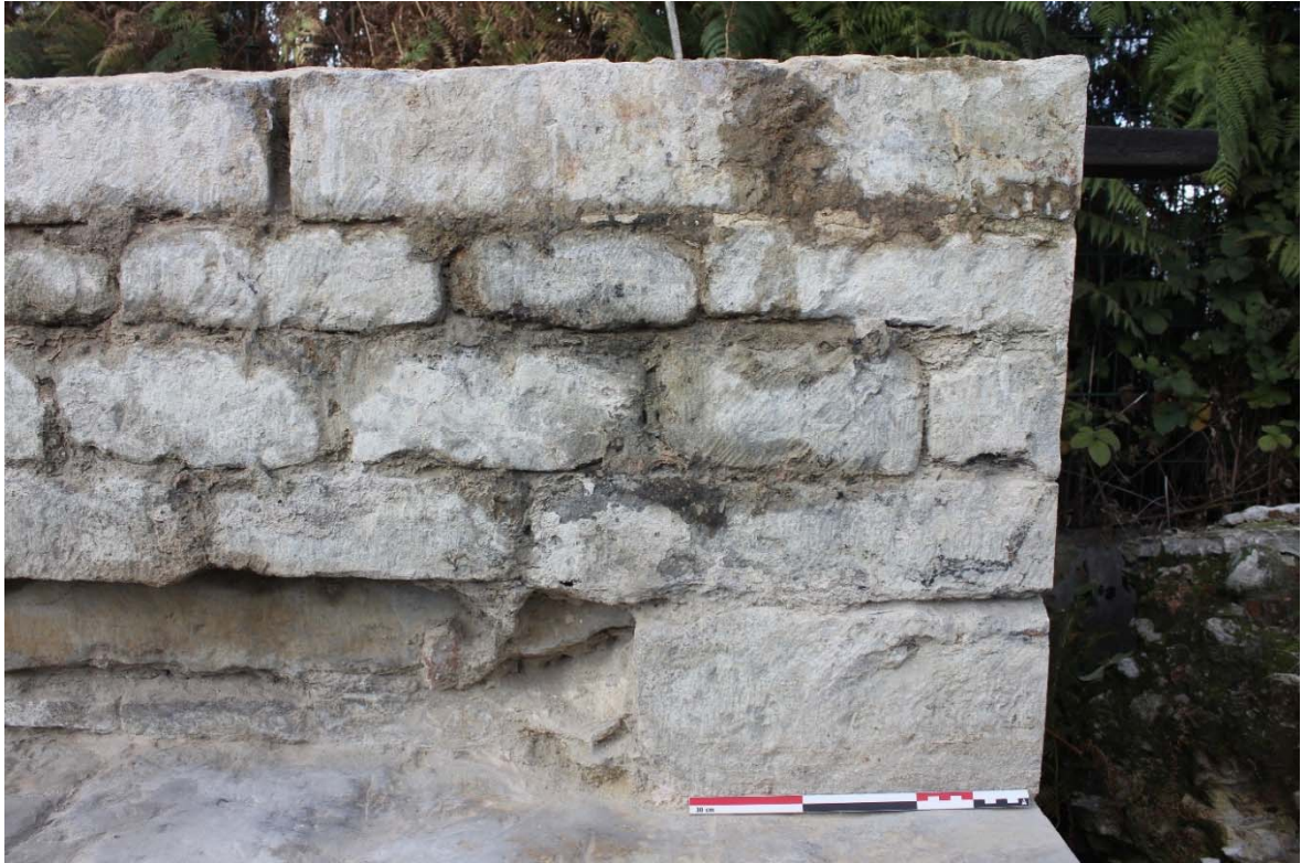
Fig. 17 : parement des moellons à têtes dressées mêlant taille fine perpendiculaire serrée et taille oblique moins soignée (bloc n°9). Photographie : Antoine Baudry (BR346_20220929_033_ABaudry). © urban.brussels-ULiège.
