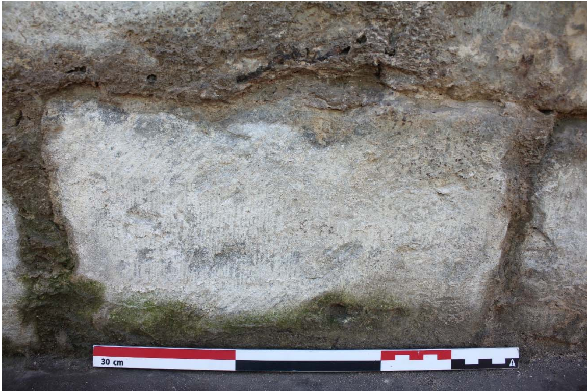
Fig. 19 : taille fine perpendiculaire serrée au tranchant droit (marteau taillant, polka ou charrue), avec palette aux impacts obliques (bloc n°9). Photographie : Antoine Baudry (BR346_20220929_014_ABaudry). © urban.brussels-ULiège.
