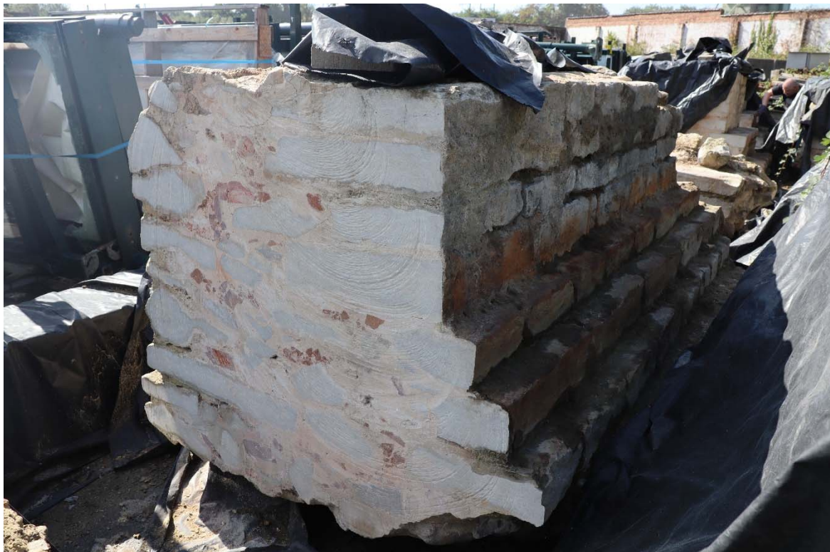
Fig. 4 : vue générale d'une coupe réalisée à la scie diamantée révélant la fourrure de la maçonnerie avec des briques fragmentaires (bloc n°1). Photographie : Valérie Ghesquière. © urban.brussels.
