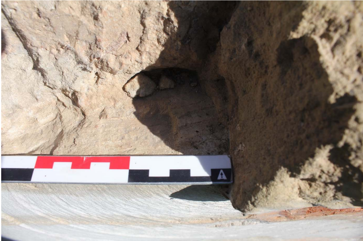
Fig. 23 : impacts de marteau taillant ou de polka sur la face d'attente d'un moellon (bloc n°6). Photographie : Antoine Baudry (BR346_20220929_008_ABaudry). © urban.brussels-ULiège.
