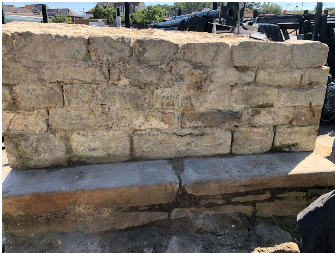
Fig. 1 : portion du mur de quai sciée au câble diamanté et aujourd'hui conservée au dépôt du département des travaux de voirie de la ville de Bruxelles (bloc n°6). Photographie : Valérie Ghesquière. © urban.brussels.
