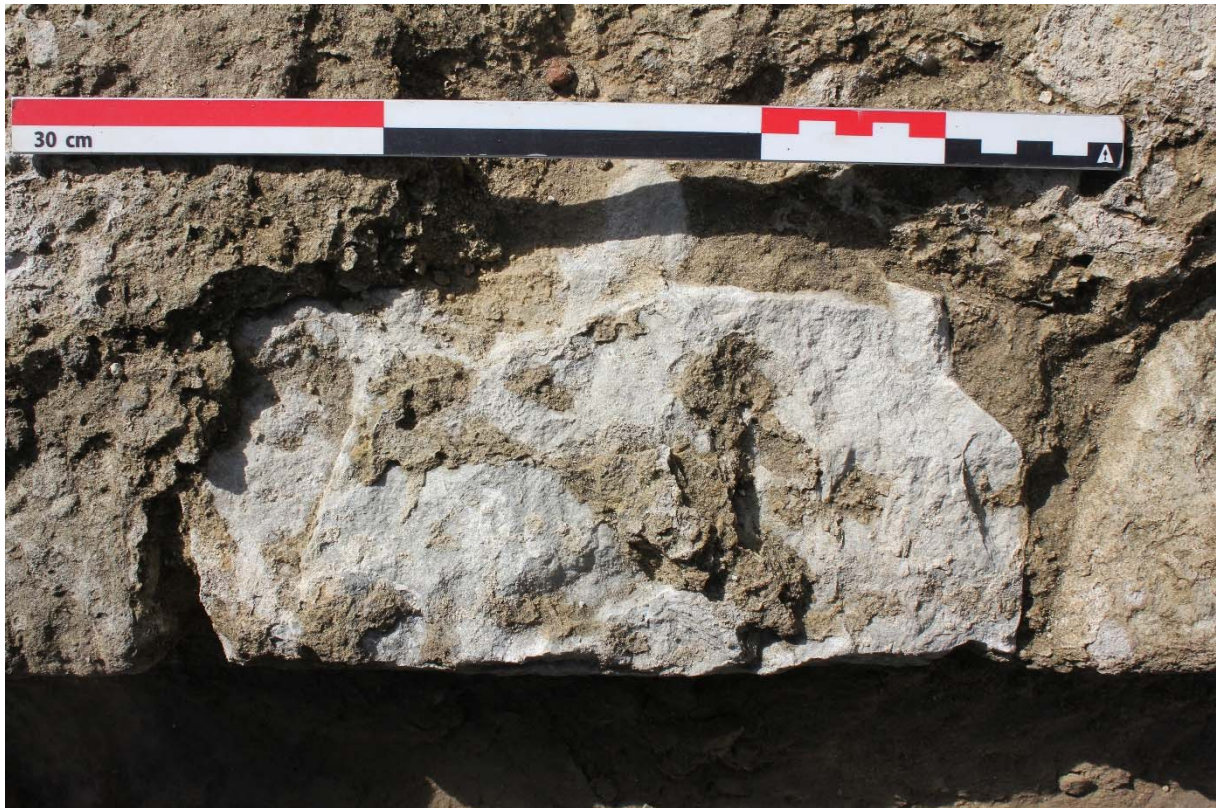
Fig. 11 : face d'attente d'un moellon à tête dressée. Faces latérales non dressées (bloc n°6). Photographie : Antoine Baudry (BR346_20220929_028_ABaudry). © urban.brussels-ULiège.
