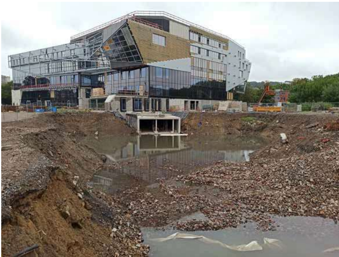
Fig. 32 : Kunysz P. (2021). Photographie de chantier depuis le quai de la Dérivation. 16/07/21
