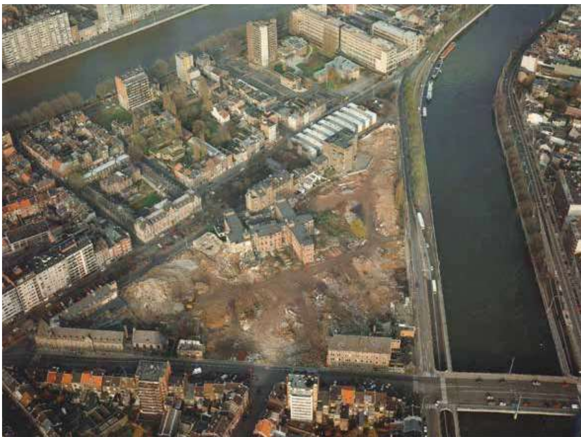
Fig. 5 : Drèze A. (ca. 1992). Photographie aérienne des démolitions de Bavière
