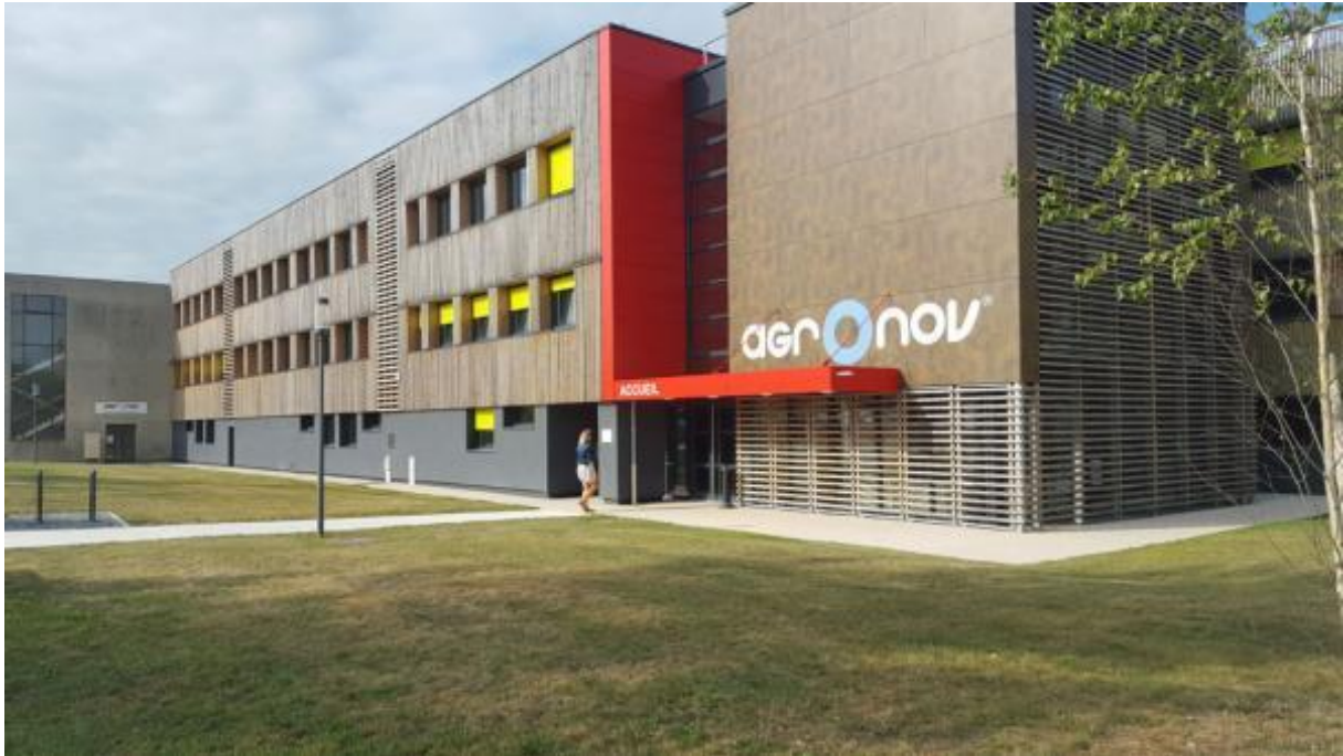
Image 19. Vue sur le bâtiment principal Source : https://agronov.com/
