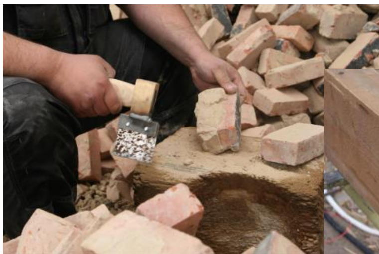
Nettoyage des restes de mortier
