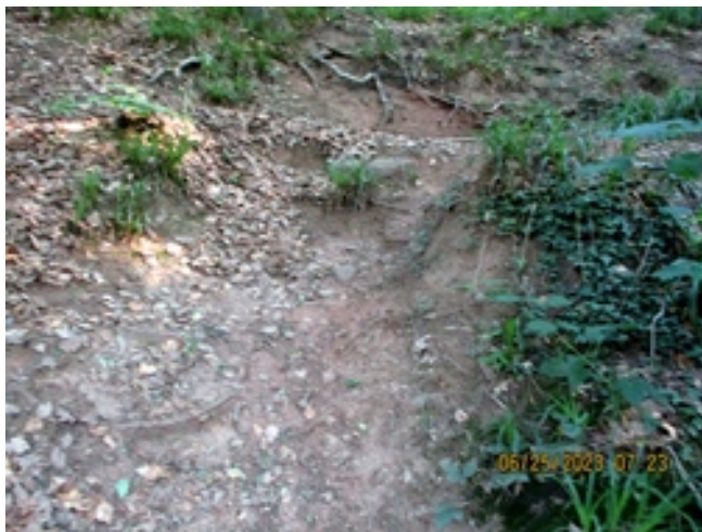
Dégradation d'un talus le long du sentier menant à la Roche tournante.
