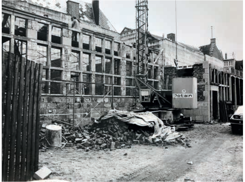
L'« îlot archéologique » en cours de construction.
