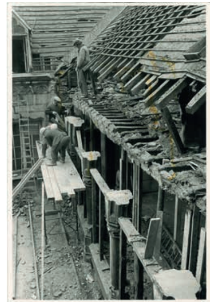
Une façade de l'hôtel de Cortenbach en cours de démontage, 1974.
