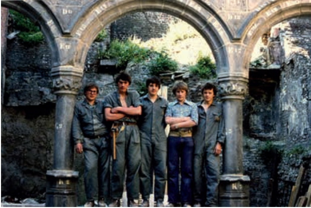
Les arcades de l'hôtel de Cortenbach remontées temporairement par un groupe d'étudiants en architecture, date inconnue.
