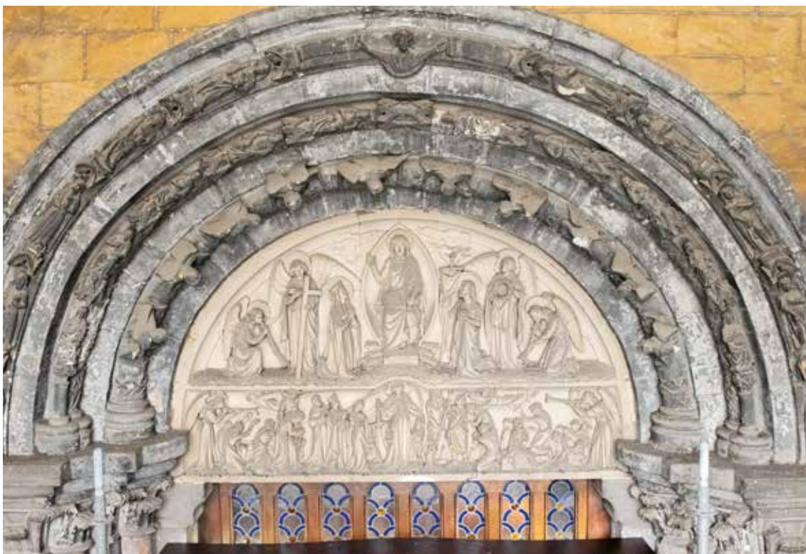
Abb. 3: Tongeren, Portal aus dem 13. Jahrhundert in der Vorhalle (Foto: E. Joly)
