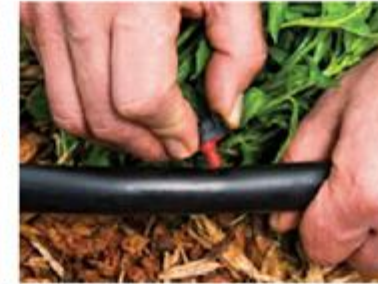
Installation d'un goutteur
