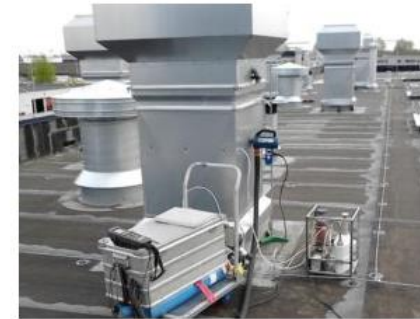
Emissie / Buitenlucht / Arbo/ Binnenlucht
