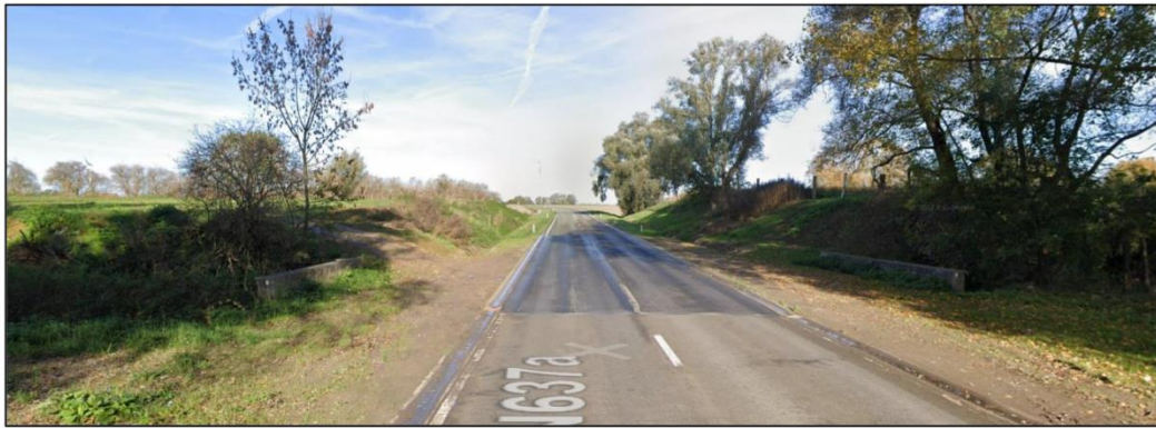
Pont entre H-s-G et Waremme – rue de Boëlhe
