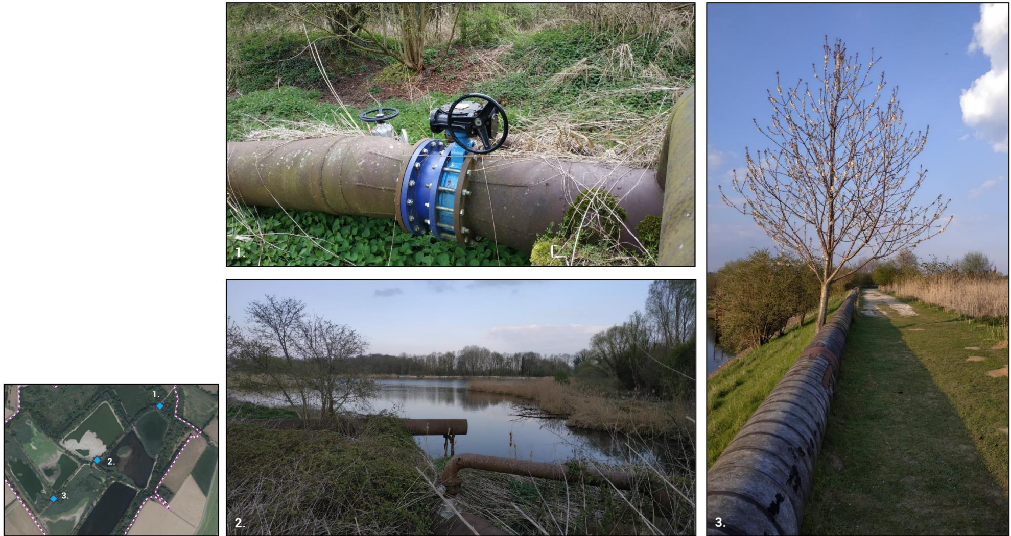
Figure 26 : les bassins de décantation et la présence de plusieurs conduites (Todaro, 2023)
