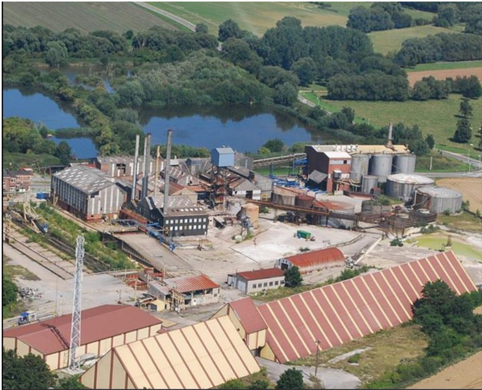
Figure 22 : vue aérienne de la sucrerie et des bassins de décantation au nord (lavenir.net, 2013)
