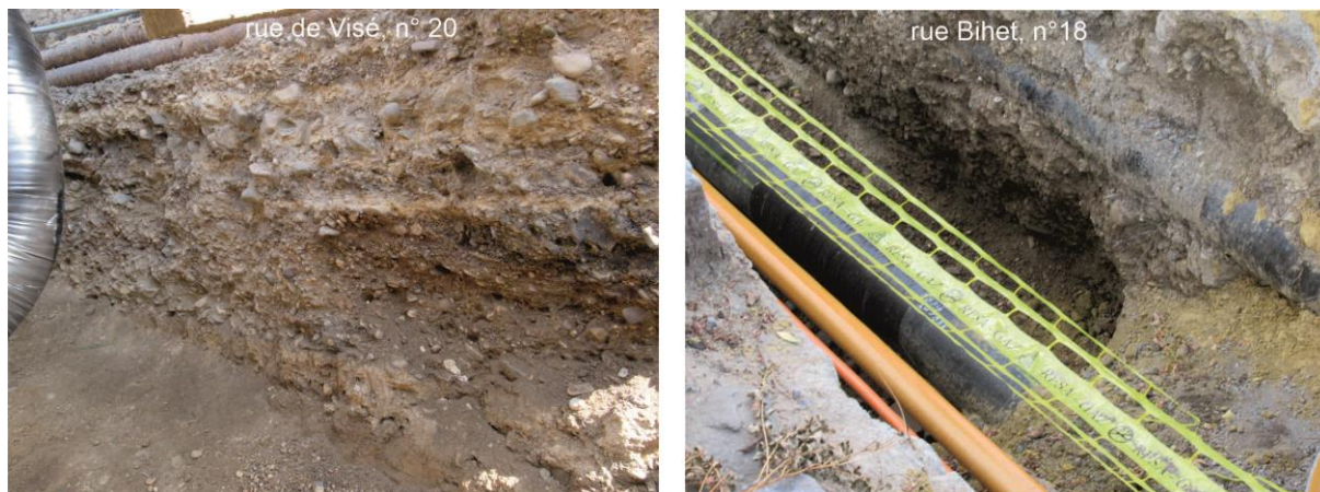
Figure 5. Cailloutis mosan dans des tranchées de la rue de Visé et de la rue Bihet.
