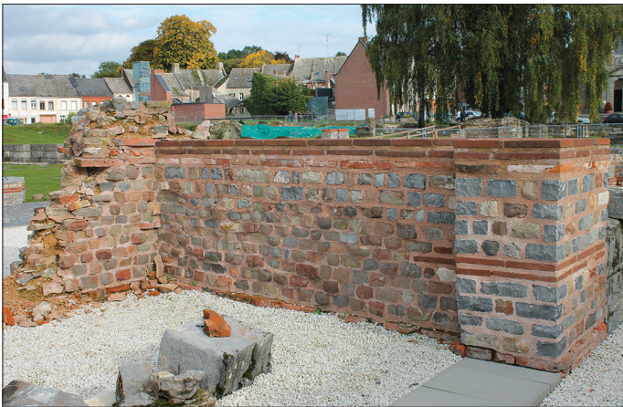
Fig. 15 – Mur de refend RB4 (fait architectural 45 ; technique H), son extrémité (fait architectural 46 ; technique J) et le mur de fond MPT05 (fait architectural 41 ; technique H) dans la boutique extérieure BO05 de l'esplanade (cliché : C. Louvion).
