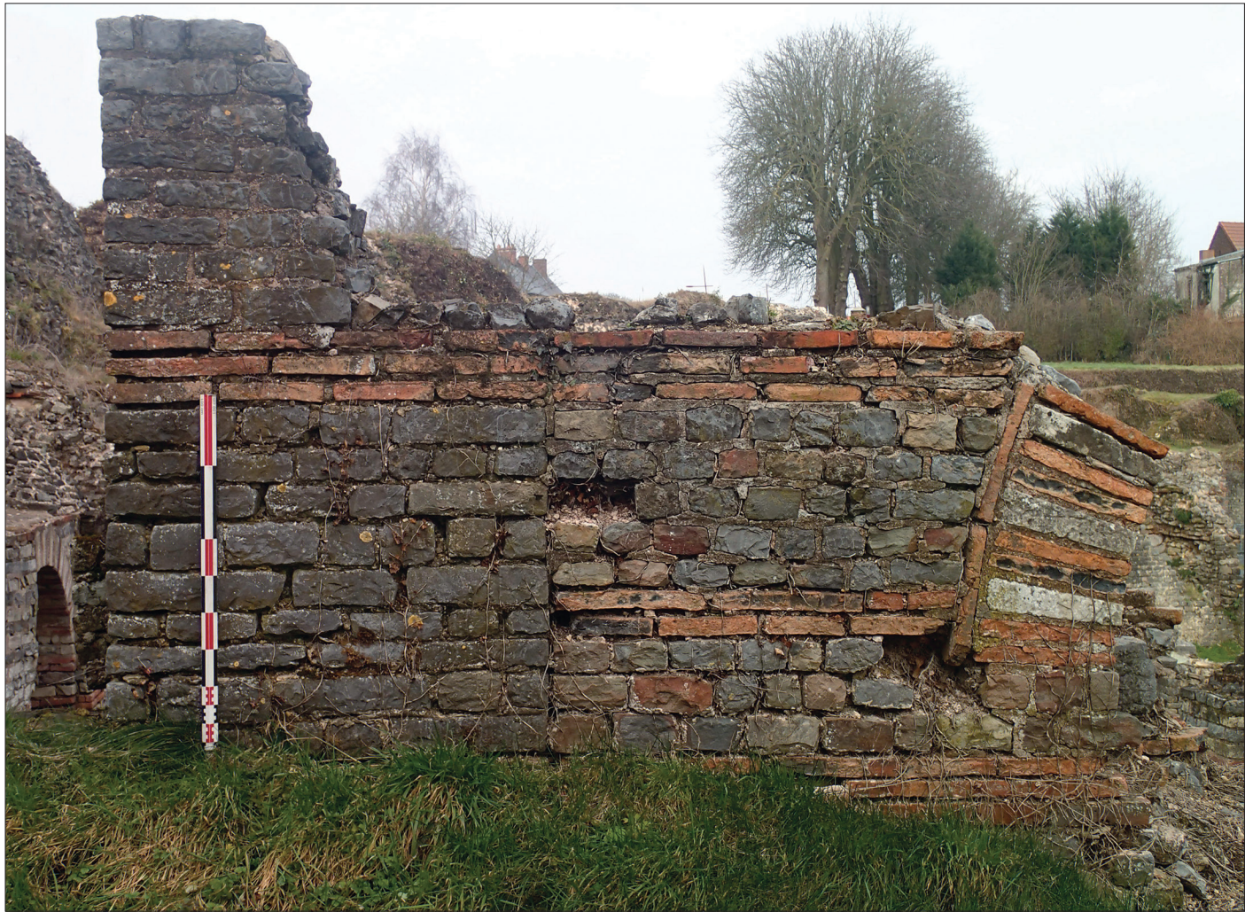
Fig. 13 – Arc de décharge (technique AB) à l'extérieur de l'édifice occidental (MEO13).
