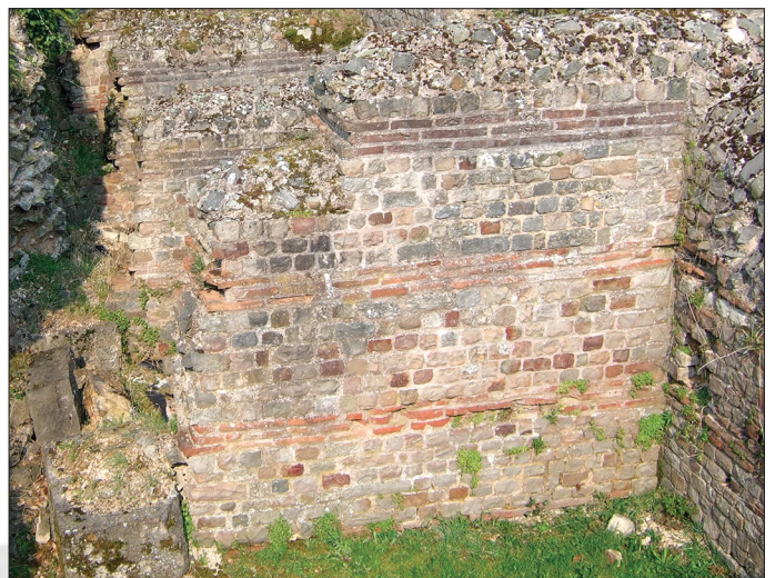
Fig. 19 – Mur de refend BB01 (fait architectural 68 ; technique F) des loges inférieures soutenant la terrasse de l'espace basilical (cliché : C. Louvion).
