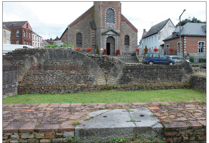
Fig. 17 – Mur MBG11-12 (fait architectural 64 ; technique C) de l'espace basilical ; les arcs de décharge sont en calcaire blanc (cliché : C. Louvion).
