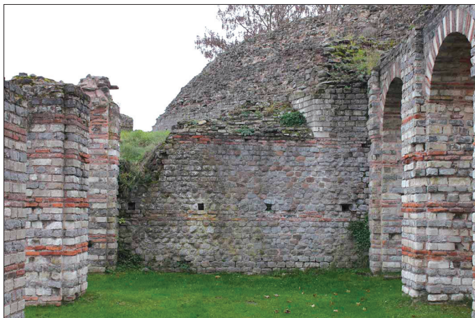
Fig. 11 – Le mur sud MEO14 (fait architectural 25 ; technique I) et les piliers P48-49 et PS07-08 (fait architectural 26 ; technique B) sous l'édifice occidental (cliché : C. Louvion).
