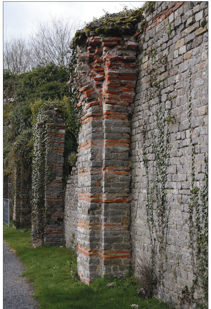
Fig. 8 – Le mur externe MCE32 conservé du premier forum, les demi-piliers PSE31-32 (fait architectural 20 ; technique A) surmontés de leur tas de charge (fait architectural 23 ; technique T) dans la branche septentrionale du cryptoportique (cliché : C. Louvion).
