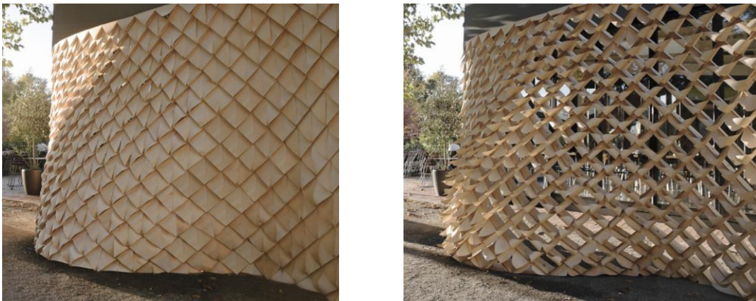
Figure 1.2: Enveloppe bio-inspirée à architecture météo-sensible fondée sur le transfert biomimétique de l'actionnement hygroscopique des cônes végétaux ( Pinophyta ) (Reichert et al., 2015)
