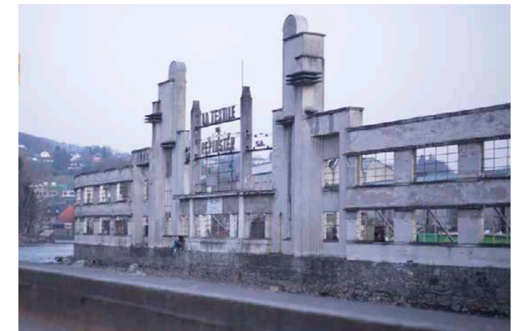
4. Façade de l'ancienne usine "La Textile" (Texter) de Pepinster @Studio
