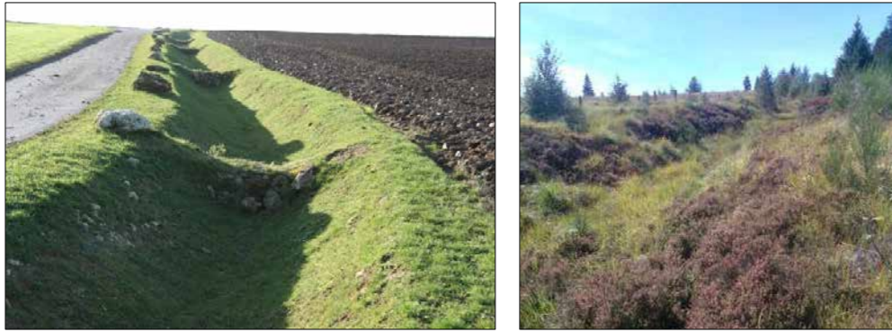
Figure 12 – Gauche : Fossé à redents (Photo : Giser 2019, projet OMER) ; Droite : Exemple de fossé végétalisé sur la Soor amont.
