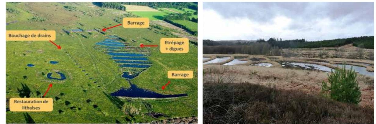
Figure 6 – Gauche : Ensemble de mesures de restauration mises en place sur le plateau des Tailles (Source : LIFE Plateau des Tailles) ; Droite : Exemple de bassins suspendus où le processus de formation de la tourbe est relancé (Photo : Ph. Frankard - DEMNA).
