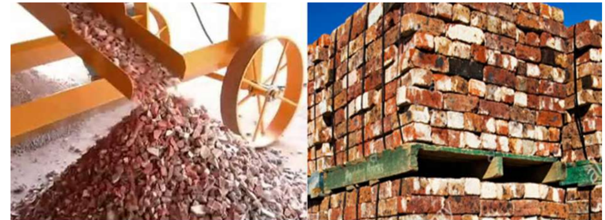
Figure 7 – Broyage de briques pour recyclage sous forme de granulats (a) et palettes avec briques pour réutilisation (b).
