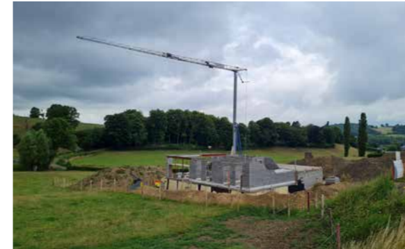
Construction d'une maison individuelle vers Baelen @Studio
