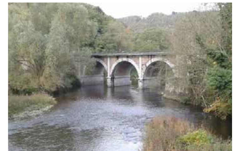
6. Ancien viaduc à Pepinster, vue depuis la N68 @Studio
