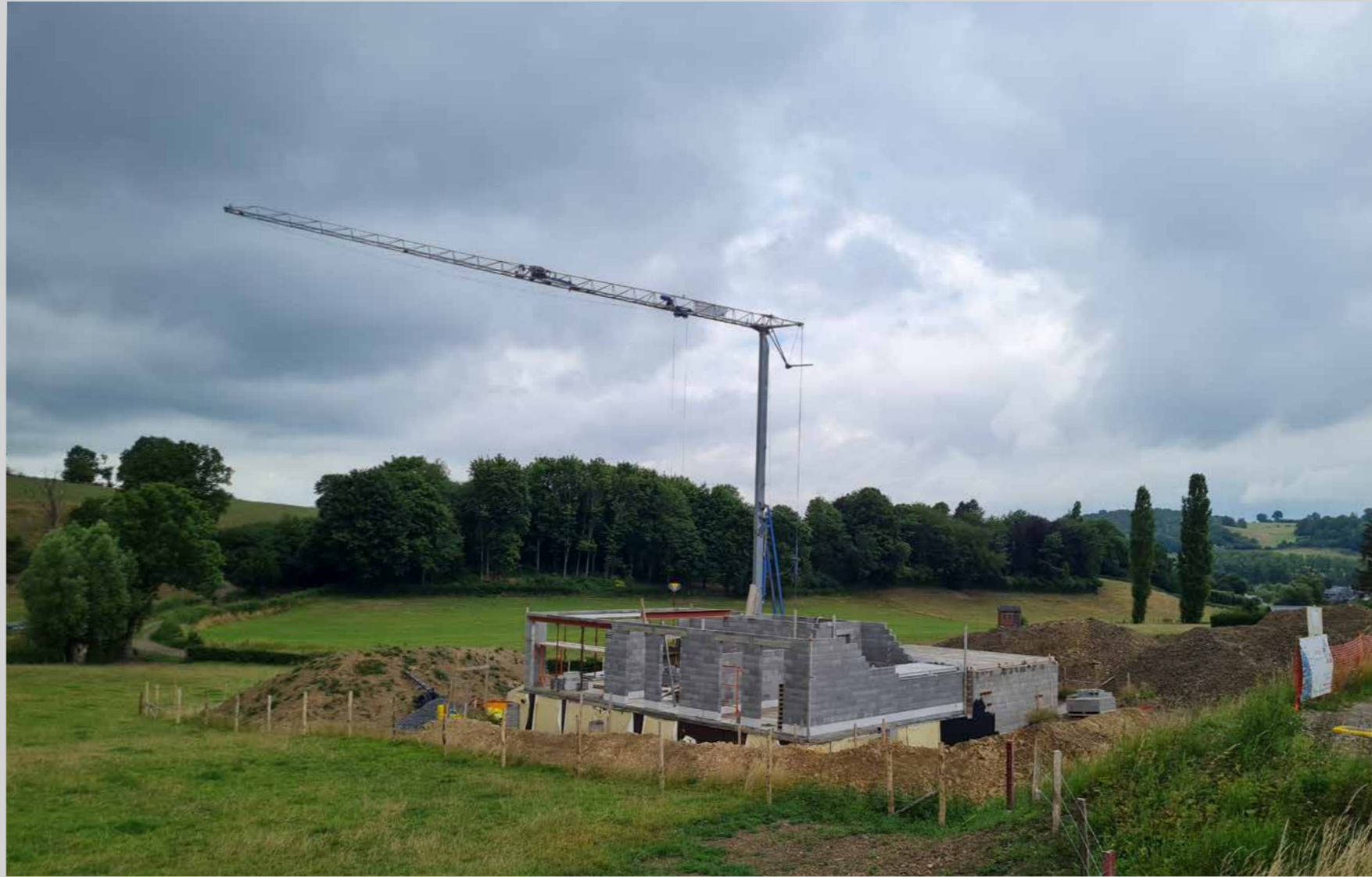
Construction d'une maison individuelle à Baelen, 2022
