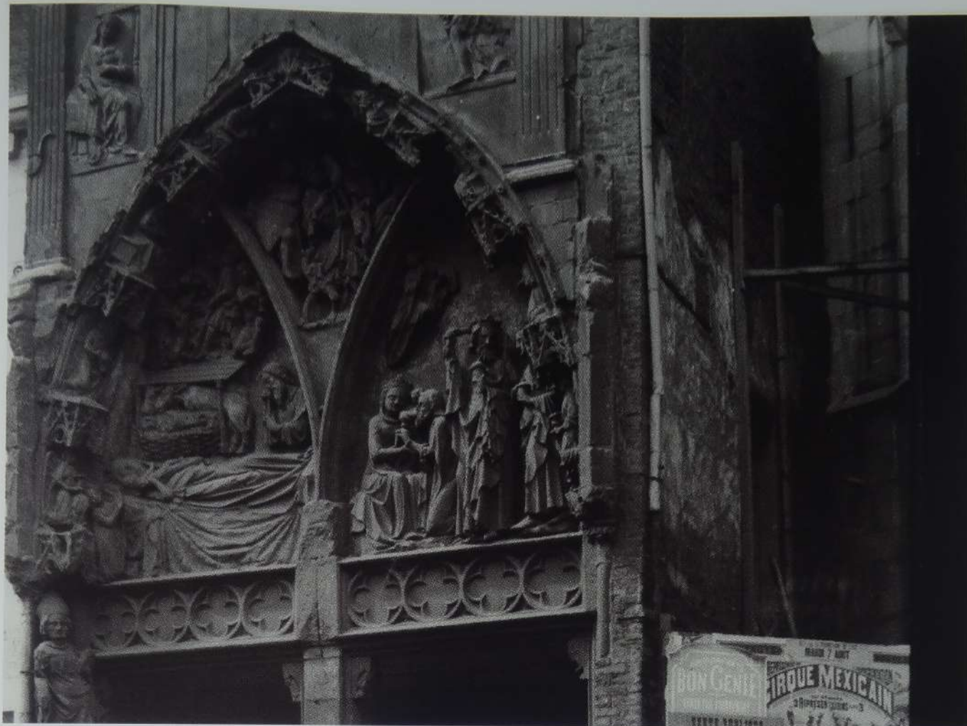
Fig. 4 Le portail « étauçonné » après démolition de la sacristie
