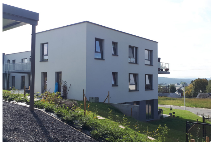
Namur. Les immeubles s'intègrent dans le relief (garages vélo et voiture semi-enterrés). Les ouvertures paysagères sont maintenues.
