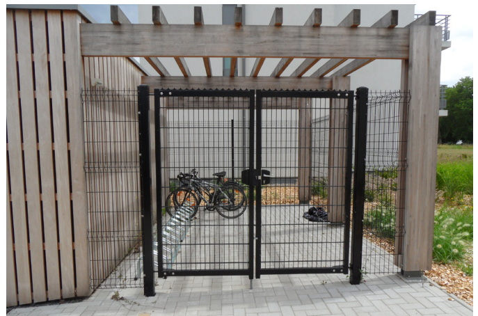
Mons. Intégration architecturale d'un parking vélo sécurisé mutualisé.
