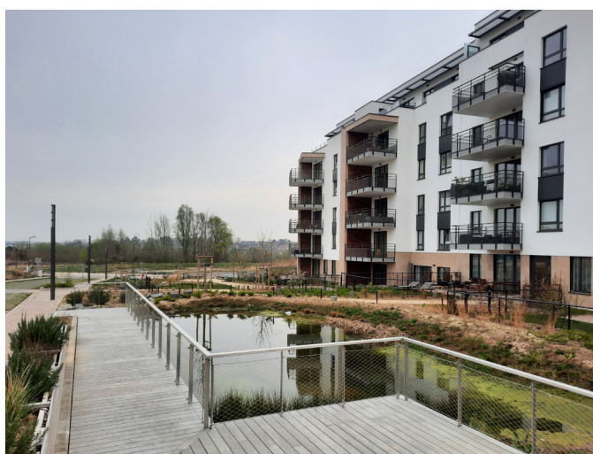
Braine-l'Alleud. La gestion des eaux de pluie peut être mise en scène via l'aménagement qualitatif des espaces publics.
