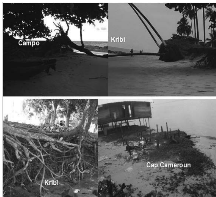
Planche 1 : Cas d'érosion sur le littoral camerounais
