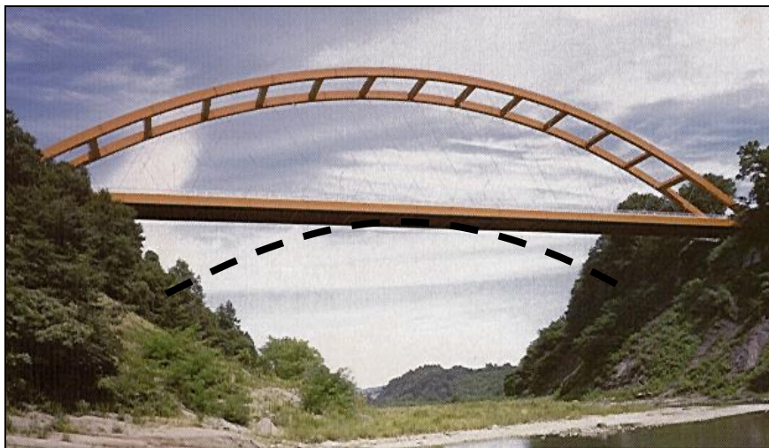
Photo 1 : Pont de la Tomoegawa au Japon (portée 171 m) : les montants qui relient les 2 arcs parallèles empêchent leur flambement latéral. Dans ce cas, une disposition des arcs au dessus du tablier semble discutable.
