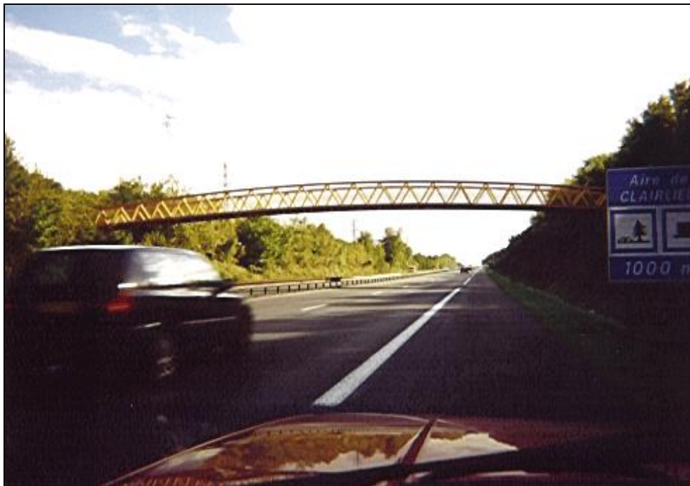
Photo 4 : la superbe passerelle en treillis sur l'autoroute E23 à Nancy qui relie la forêt de Haye au parcours santé de la sapinière.
