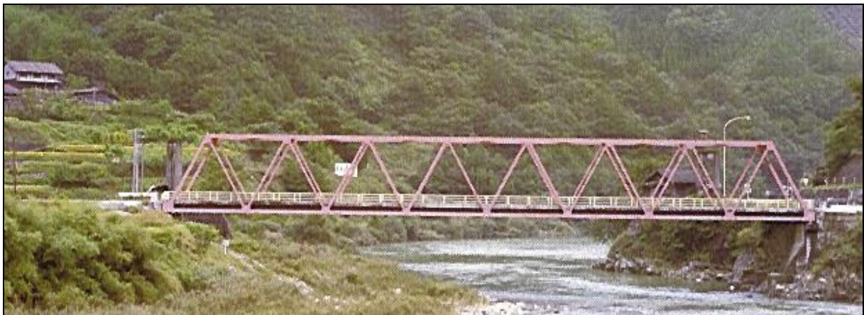
Photo 2 : pont Warren sur la rivière Hida au Japon.
