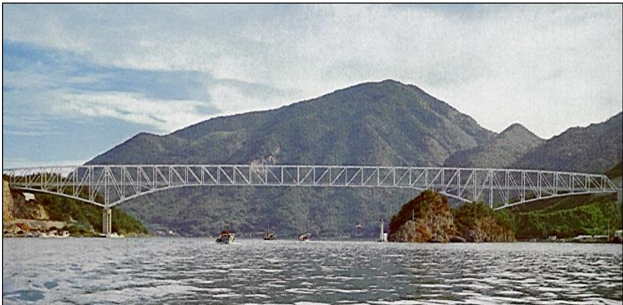
Photo 1 : pont de Tenmon au Japon. La structure à base de treillis Pratt semble extrêmement légère.
