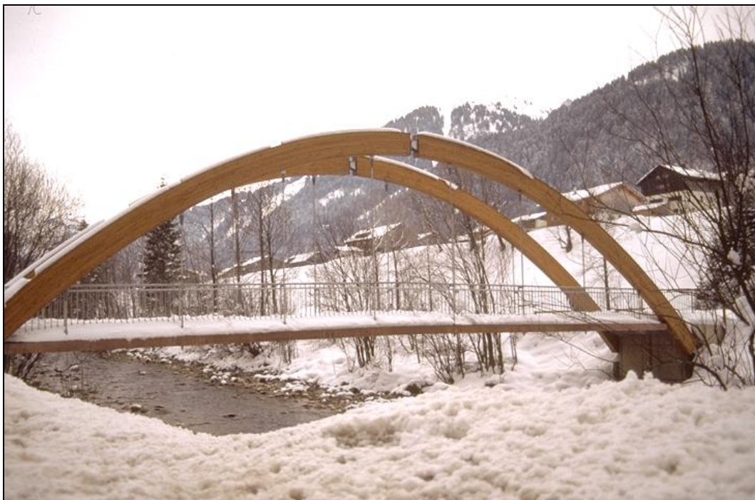
Photo 5 : passerelle en arc à Schröken (Autriche). Dans cette situation où la portée est très faible, le choix des arcs semble ne se justifier que pour des raisons architecturales. Ils pourraient avantageusement être remplacés par deux simples poutres droites servant de support au tablier, éventuellement dotées d'une contre-flèche.
