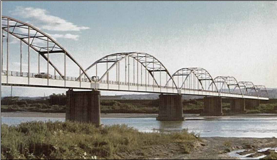
Photo 3 : succession de bow-strings : les arcs paraissent bien inutiles face au gabarit du tablier qui aurait à lui seul probablement suffit.
