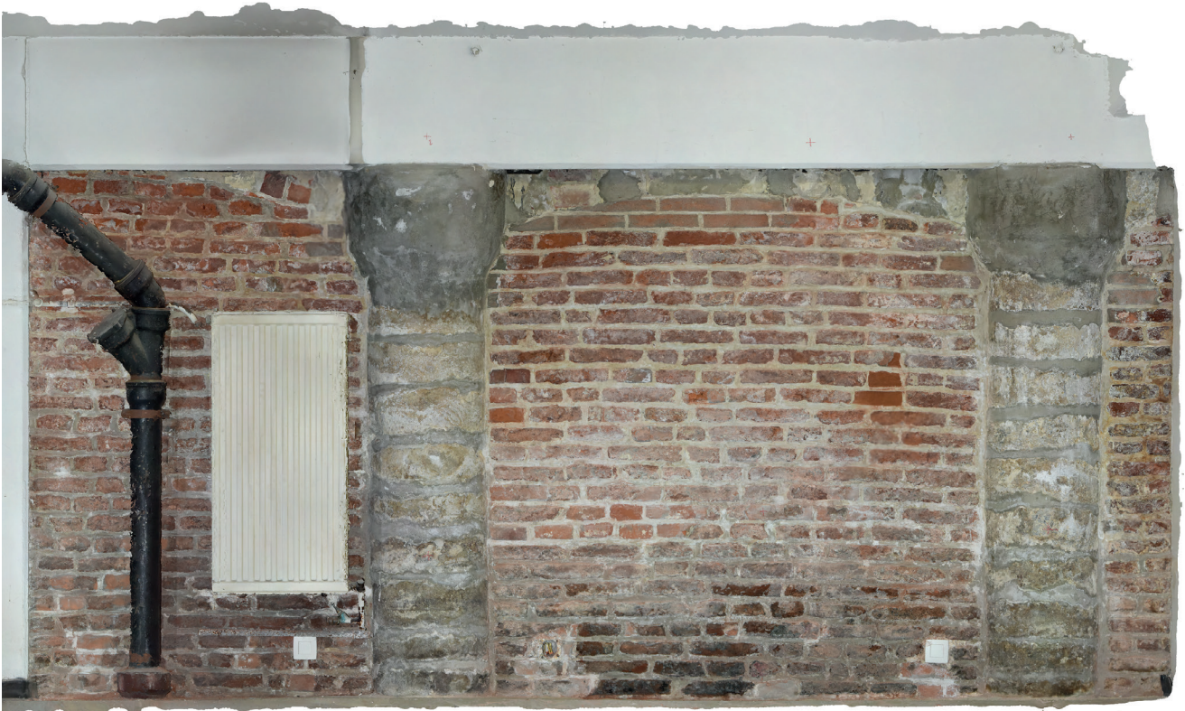
Fig. 1 Orthophotographie du mur ouest de la cave de la maison rue du Marché-au-Charbon 9, montrant les piliers en calcaire gréseux, les vestiges de part et d'autre des arcs doubleaux longitudinaux et la cloison en briques érigée pour séparer en deux parties l'ancienne cave à deux vaisseaux (© ULB-urban.brussels ; DAO : Benjamin Van Nieuwenhove).
