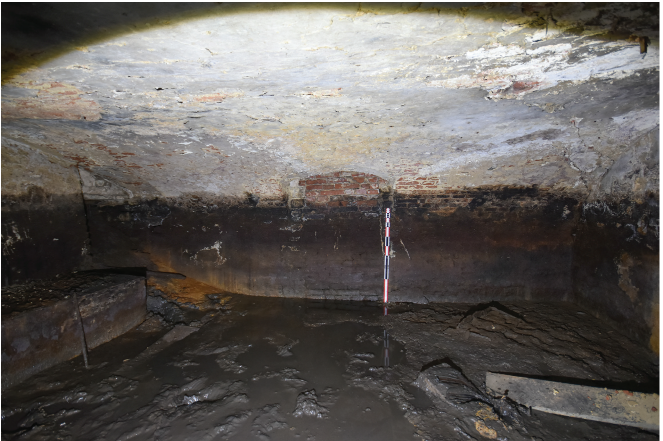
Fig. 3 Photographie du mur sud de la salle nord de la cave de la ferme du Castrum et la baie de porte permettant la communication avec la salle sud (© ULB-urban.brussels ; cliché : Paulo Charruadas).
