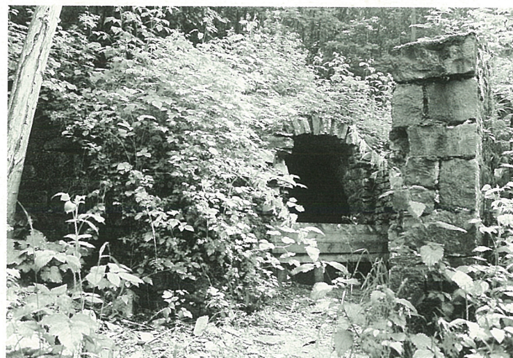
30. La glacière dégagée après les premiers travaux.
