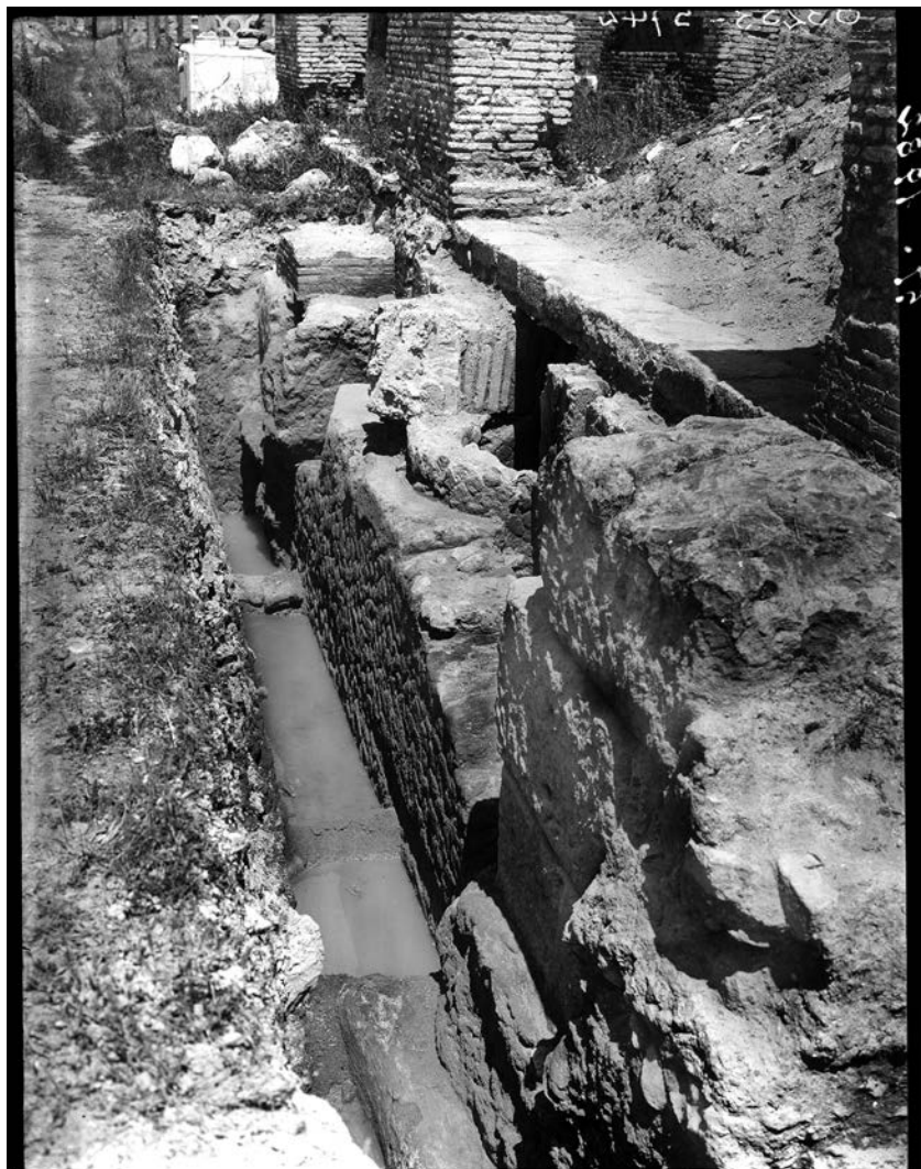
Fig. 3 – Structures découvertes dans le sondage B4, ouvert au pied du portique du Caseggiato del Portico con Fontana a Lucerna (IV, vii, 1) par I. Gismondi. Cliché : PaOant, AF, B3253.
