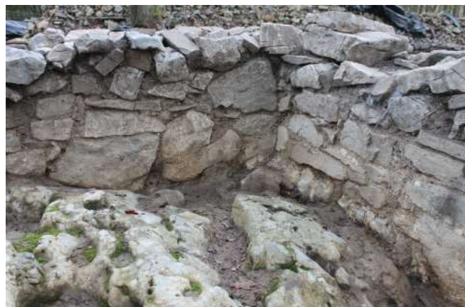
Figure 6 – Zone 17. Chaînage entre le mur gouttereau nord-ouest [257] et le mur de refend [260], vue de l'intérieur du chœur.
