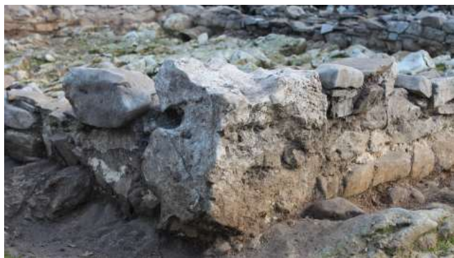
Figure 5 – Zone 17. Angle de fondation entre les murs [287] et [253].
