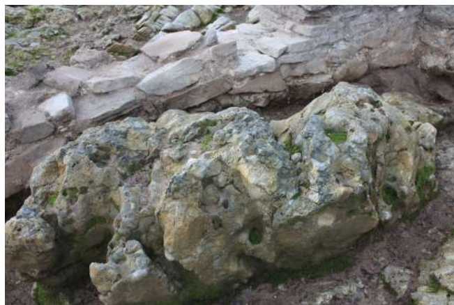
Figure 11 – Zone 17. Tête de roche martelée dans le chœur de l'oratoire.
