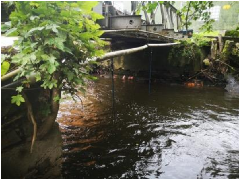
Figure 7 : Antenne SB couvrant l'aval des turbines de la CHE.
