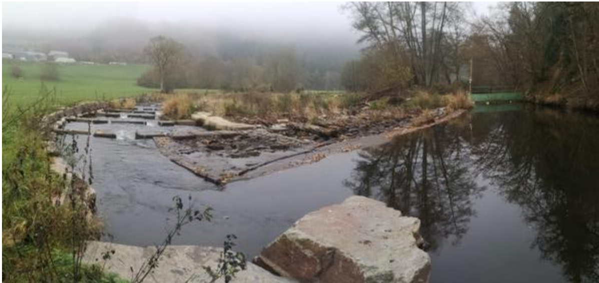
Figure 1: Photo du barrage de Weweler avec à gauche de l'image, le canal à bas débit, au centre, la passe rugueuse et à droite le canal d'alimentation de la CHE et de la pisciculture.
