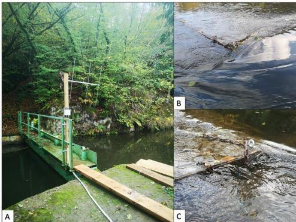
Figure 8 : Antenne SP. A) Antenne aérienne couvrant la rampe rugueuse. B) & C) Antenne subaquatique dans le bassin de sortie de la PAP.
