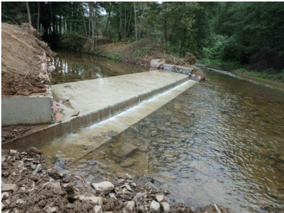
Figure 3 : Photo à bas débit du seuil immergé présent en fin de canal de fuite de la CHE de Weweler (Source DCENN).
