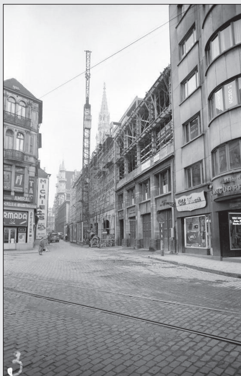
Fig. 7-8. Commissariat de quartier Centre en construction / Wijkcommissariaat Centrum in aanbouw (datum)
