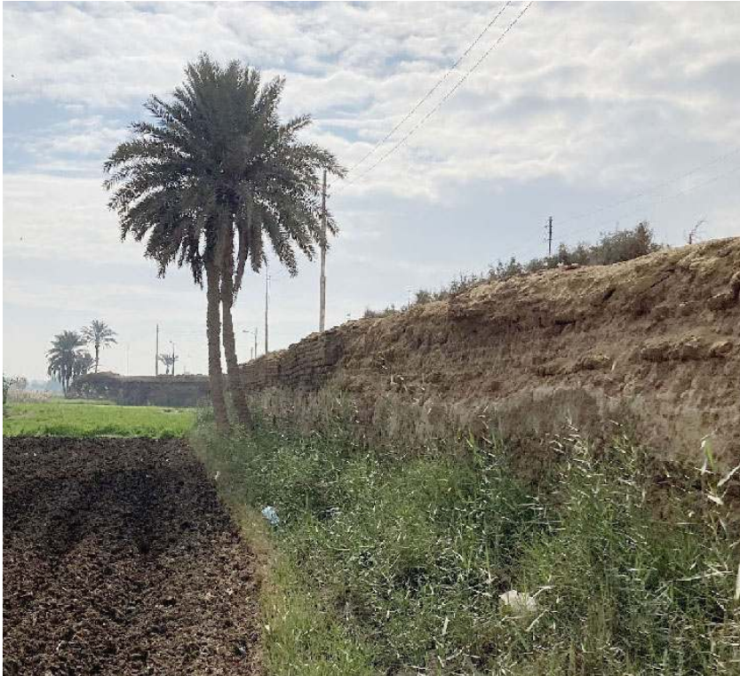
Fig. 59. Gisr en briques crues avec des phases de rénovation à El-Lahoun (J. Bunbury).
