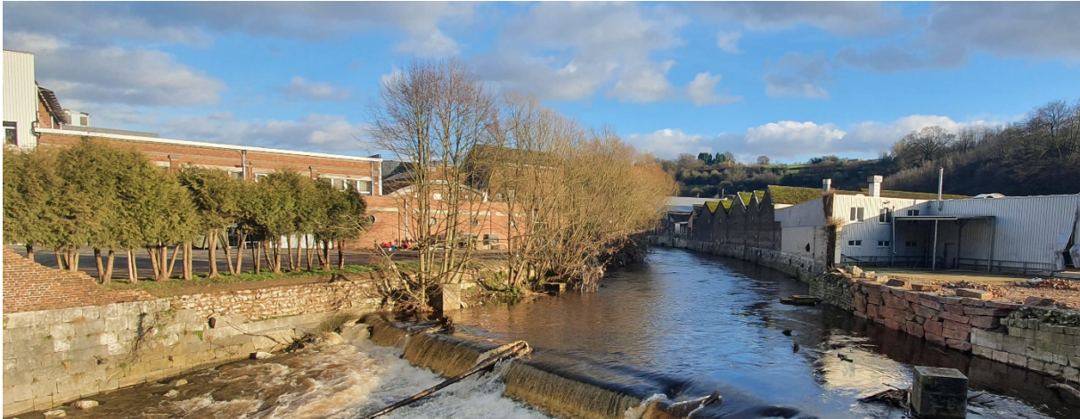
Figure 7. e.7 – Des remblais généralisés dans la plaine alluviale de la Vesdre pour permettre l'implantation d'usines. La Vesdre est ainsi canalisée par des murs de berge soutenant les remblais. Quels étaient les matériaux utilisés et quels risques pollutions diffuses dans les remblais ? J. Privot 2022.
