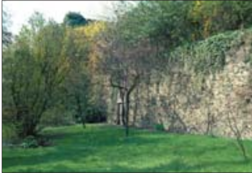
A l'arrière d'un jardin privé, un mur de soutènement , formant la limite d'une propriété, pourrait dater de l'époque des fortifications.
