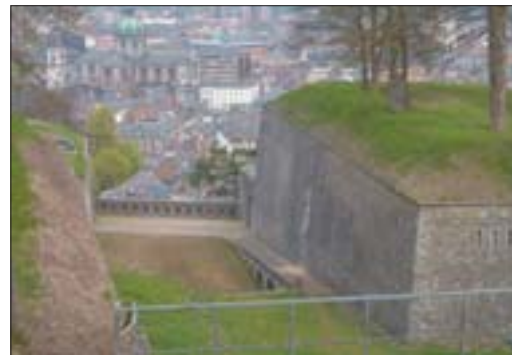
Vue du centre-ville depuis la Citadelle
