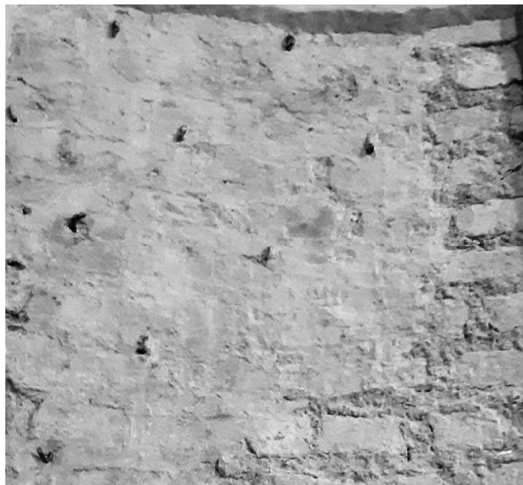
10. Grappe metalliche per sectilia ritrovate durante l'ultimo restauro (2018-2019) nella nicchia sud-ovest di Sant'Aquilino
