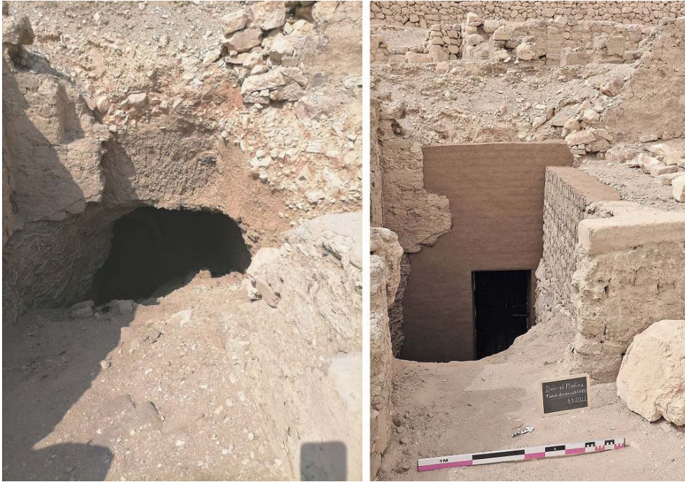
Fig. 7. Mur de soutènement et accès à la TT 355 avant et après notre intervention (A. Dorn).
