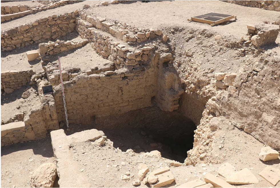
Fig. 6. Effondrement du mur est des pièces A-B et, en avant-plan, du mur nord de l'accès à la TT 355. Vue vers le sud-ouest (A. Dorn).
