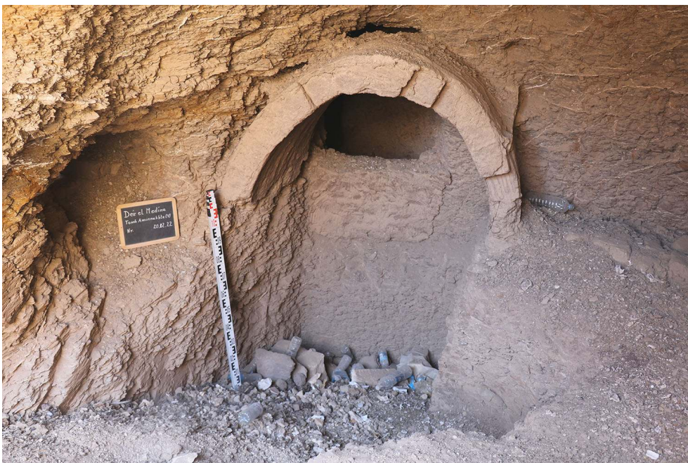
Fig. 10. Voûte en briques située au départ de la brèche vers P. 1338 qui protège l'accès aux chambres de la TT 355, dont l'entrée est située en contre-bas, sous les débris (photo avant nettoyage et construction du nouveau mur de soutènement ; A. Dorn).
