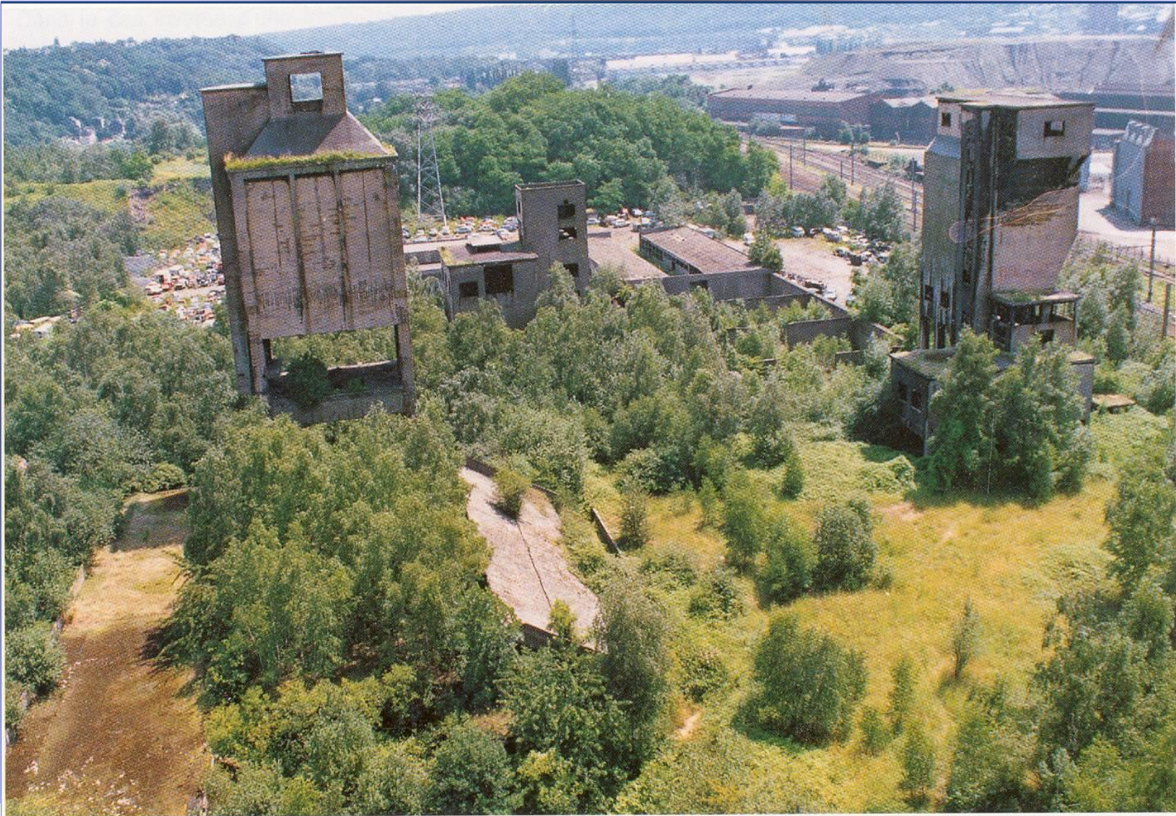
2. Site de la cokerie de Tilleur; les bâtiments sont aujourd'hui démolis dans le cadre de l'assainissement du site par la SORASI (photo GEHAT 1992).
