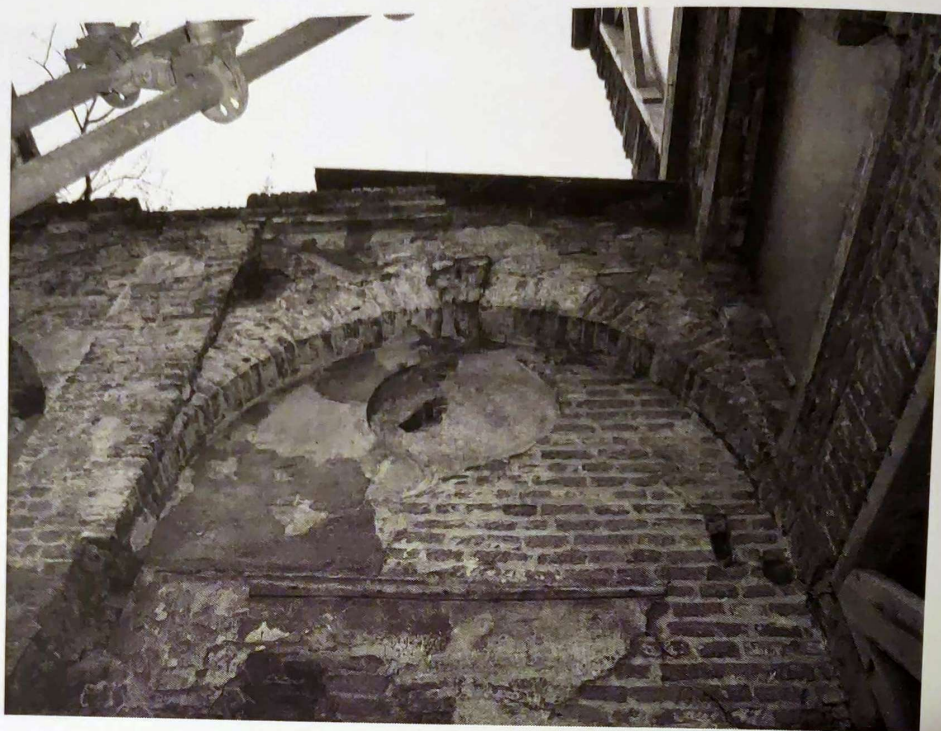
Fig. 10. Maison Dewez, Remise à carrosse et écuries, détail de la façade ouest, arcade située à l'extrémité sud, l'arcade en elle-même a été édifiée autour d'un noyau plus ancien daté entre le XIV e et le XVI e s. (P. Sosnowska © MRAH-MRBC).
