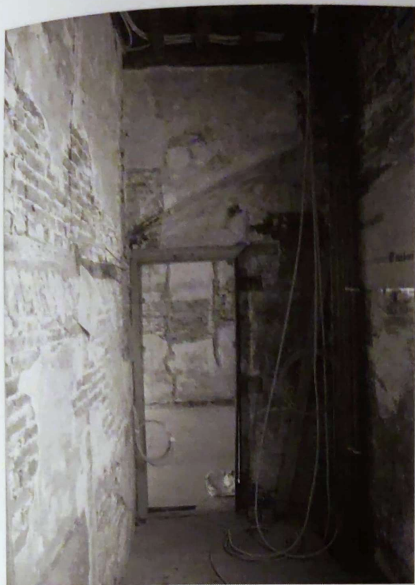
Fig. 23. Maison Dewez, premier étage du n°73, conduit de la cheminée d'angle de la pièce 73/1/9 (P. Sosnowska © MRAH-MRBC).
