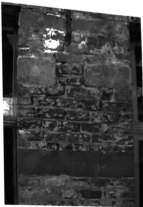
Fig. 15. Maison Dewez, façade nord du n°73, détail d'un trumeau dont la maçonnerie se caractérise par l'usage combiné de grès vert de Tubize et de grès lédien (P. Sosnowska © MRAH-MRBC).
