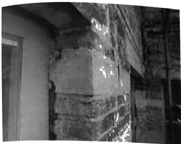
Fig. 14. Maison Dewez, façade nord du n°73, détail d'une pierre en remploi (P. Sosnowska © MRAH-MRBC).
