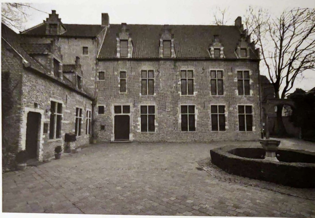
Fig. 8. Maison Erasme, Anderlecht, vue de la façade sur cour comportant des ancrs millésimées 1515 et dont le corps de bâtiment principal se caractérise par une maçonnerie à appareillage de type flamand (P. Sosnowska © MRAH-MRBC).
