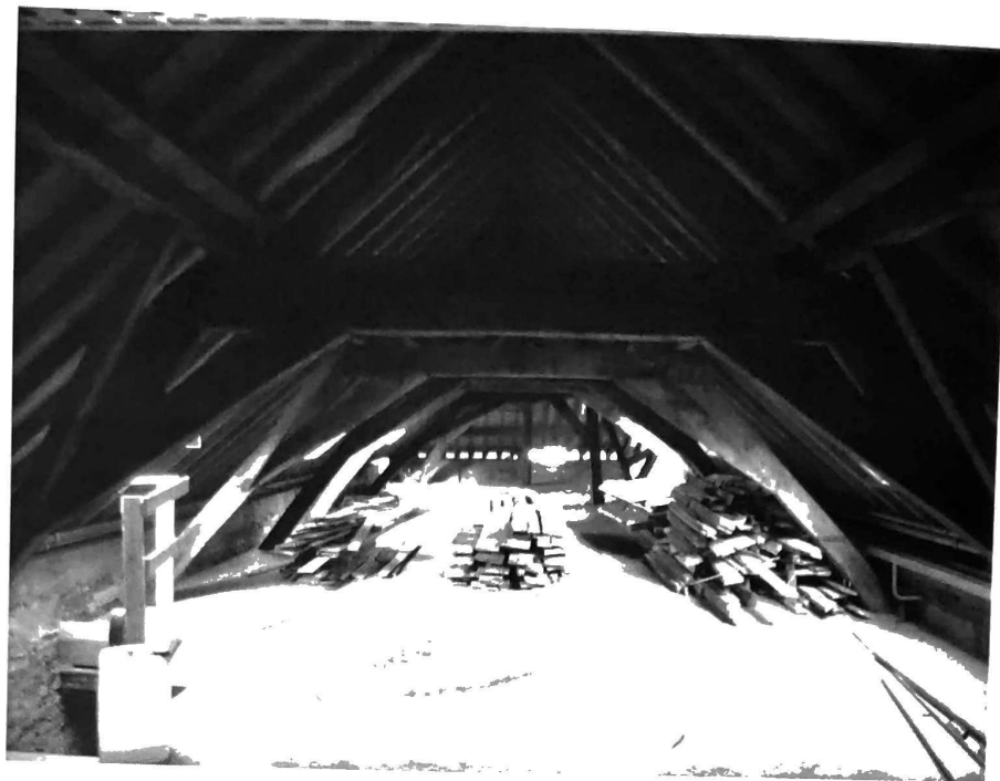
Fig. 13. Maison Dewez, comble, ferme à portique, abattage des bois datée par dendrochronologie de 1774/1776 (P. Sosnowska © MRAH-MRBC).
