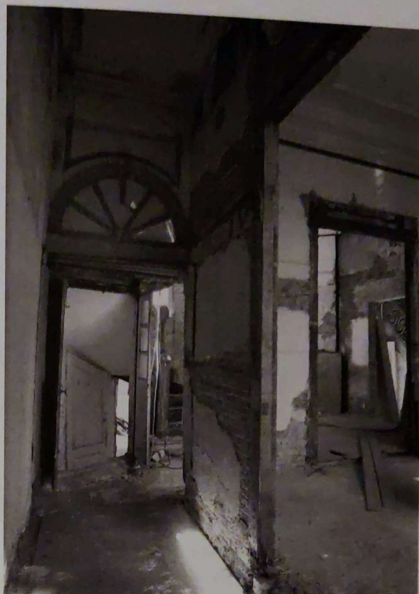
Fig. 24. Maison Dewez, rez-de-chaussée du n°75, vue du couloir et de la mise en œuvre de la cloison (P. Sosnowska © MRAH-MRBC).
