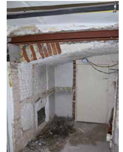
Afb. 4 Huis De Greef , Boterstraat 24-26, kelder met gedeeltelijk gewelf van het korfboogtype, gedateerd in de 15de- 16de eeuw (Ph. Sosnowska © GOB-ULB).
