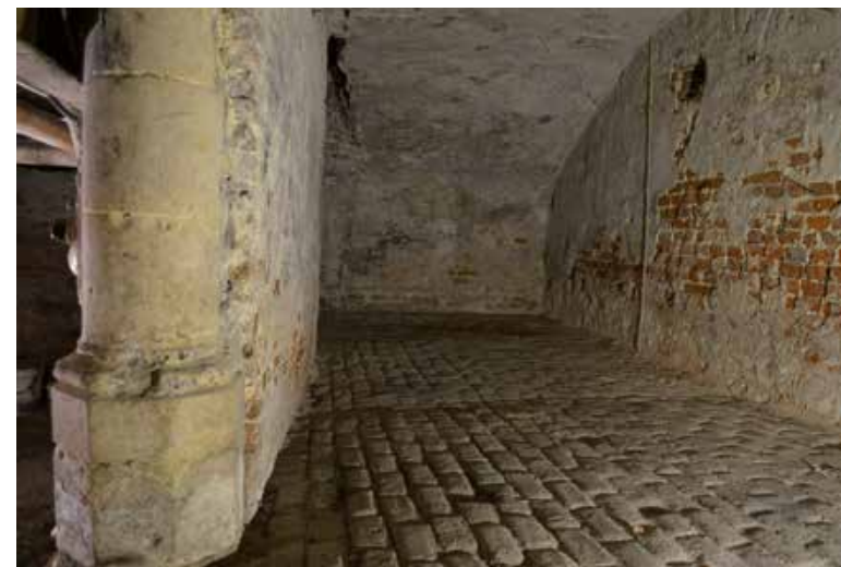
Afb. 6 Café Manneken Pis, Lievevroubroerstraat 31-33, de kelder uit het eerste kwart van de 16de eeuw en detail van de westelijke zuil die de steunmuur met schouw ondersteunt. (S. Modrie © GOB-ULB).
