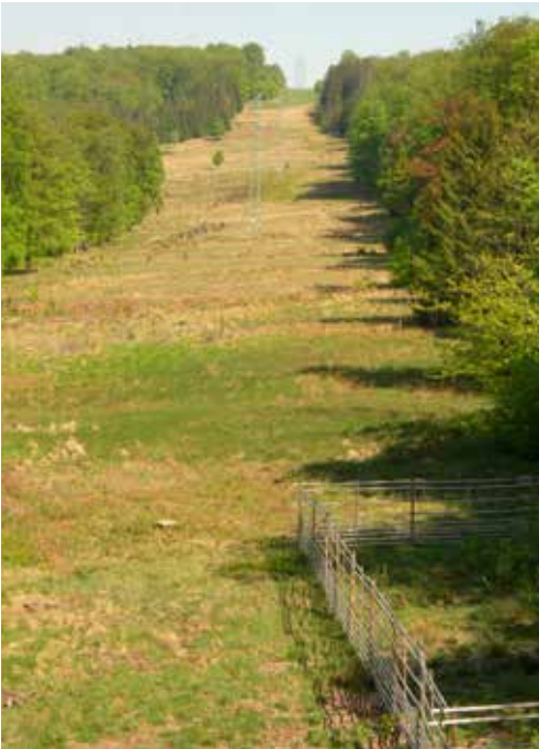
L'entretien des servitudes sous les lignes électriques à haute-tension permet de conserver la connectivité entre habitats ouverts
