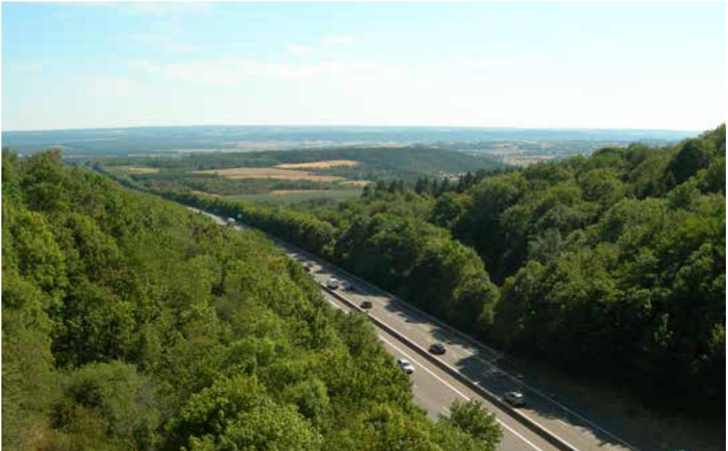
Les infrastructures de communication constituent des barrières écologiques pour de nombreuses espèces
